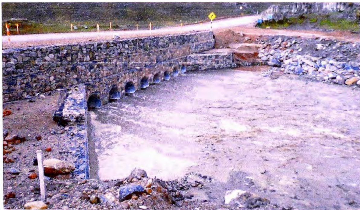
Foto 6. Construcción Alcantarillas en vía de evitamiento
