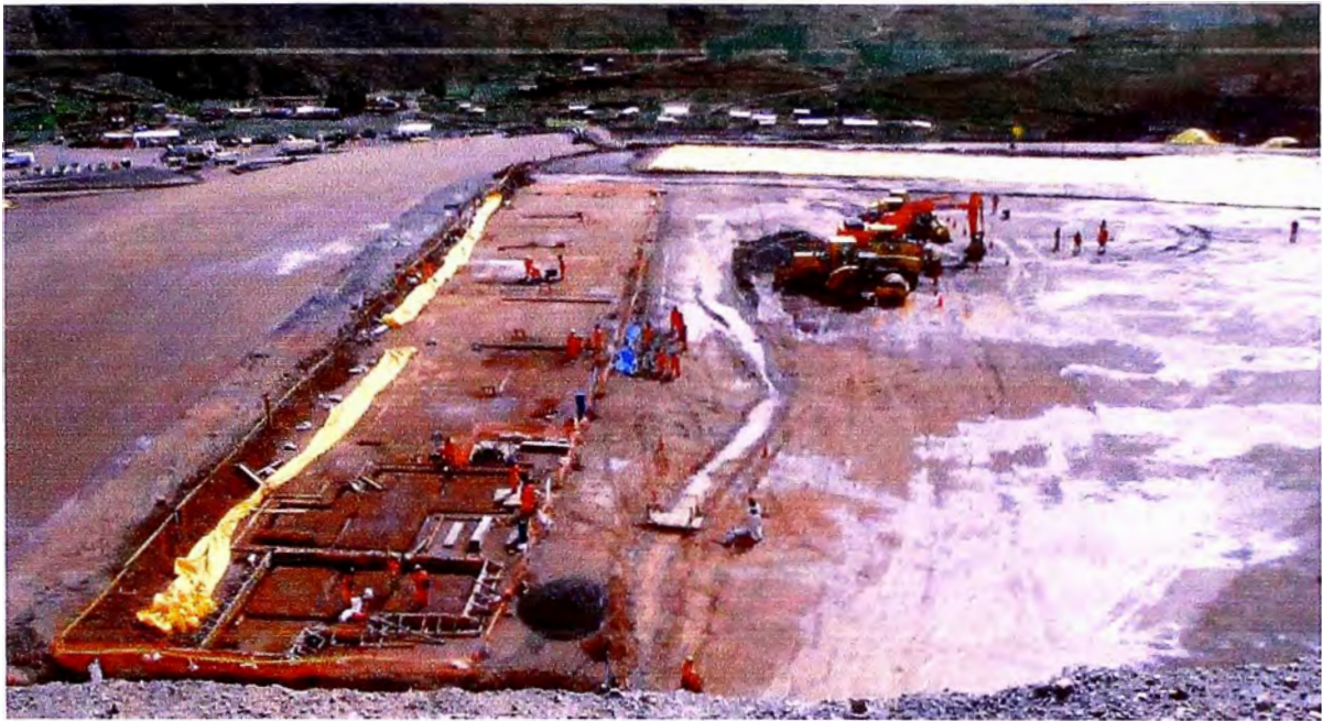
Foto 14. Trabajos de plateas de cimentación en viviendas. Rellenos de ingeniería.
