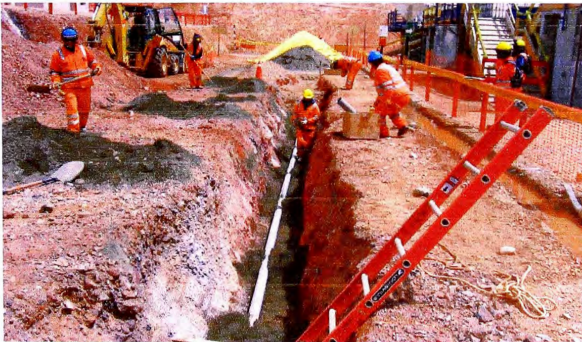
Foto 19. Instalación de tuberías de PVC para redes de agua potable.
