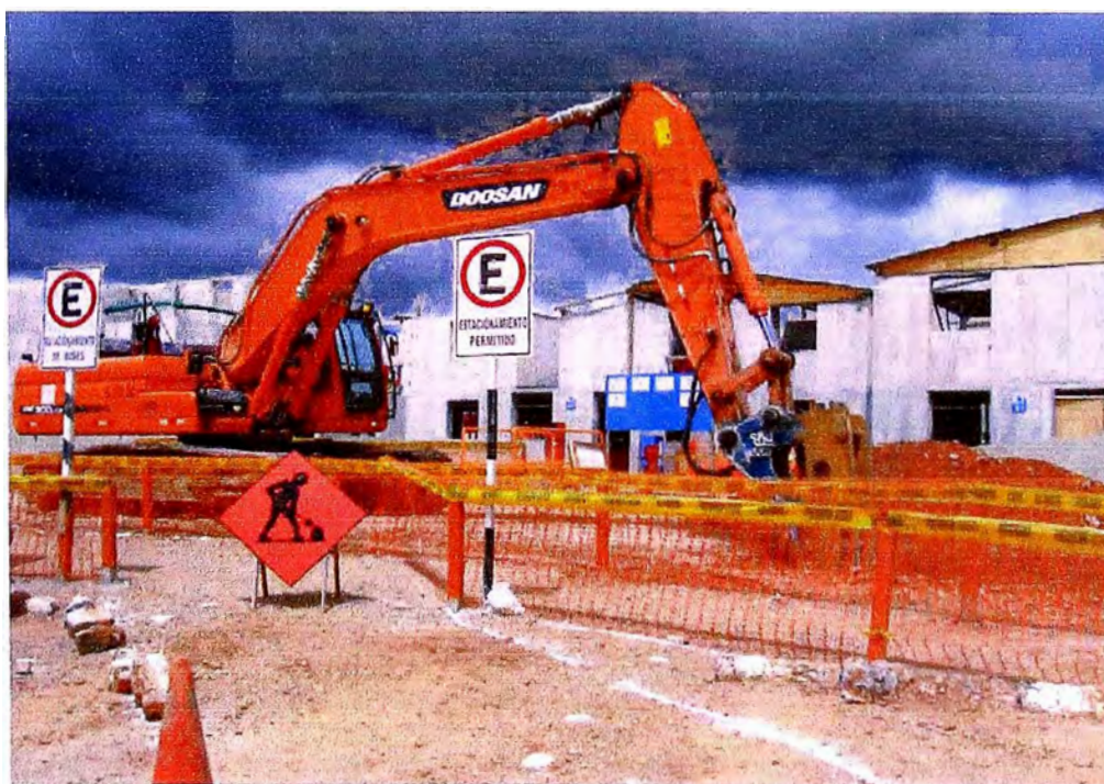
Foto 5. Fracturación de roca para excavación de zanja. Manzana "T" proyecto NFB.
