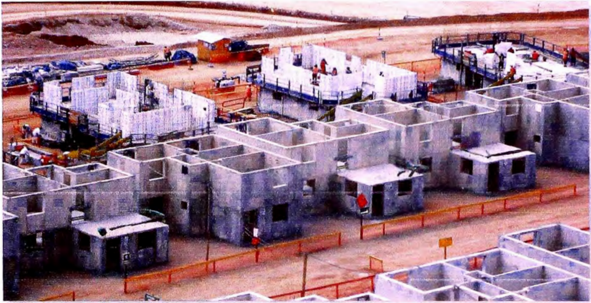
Foto 12. Vista Panorámica de la construcción de viviendas en zona oeste.
