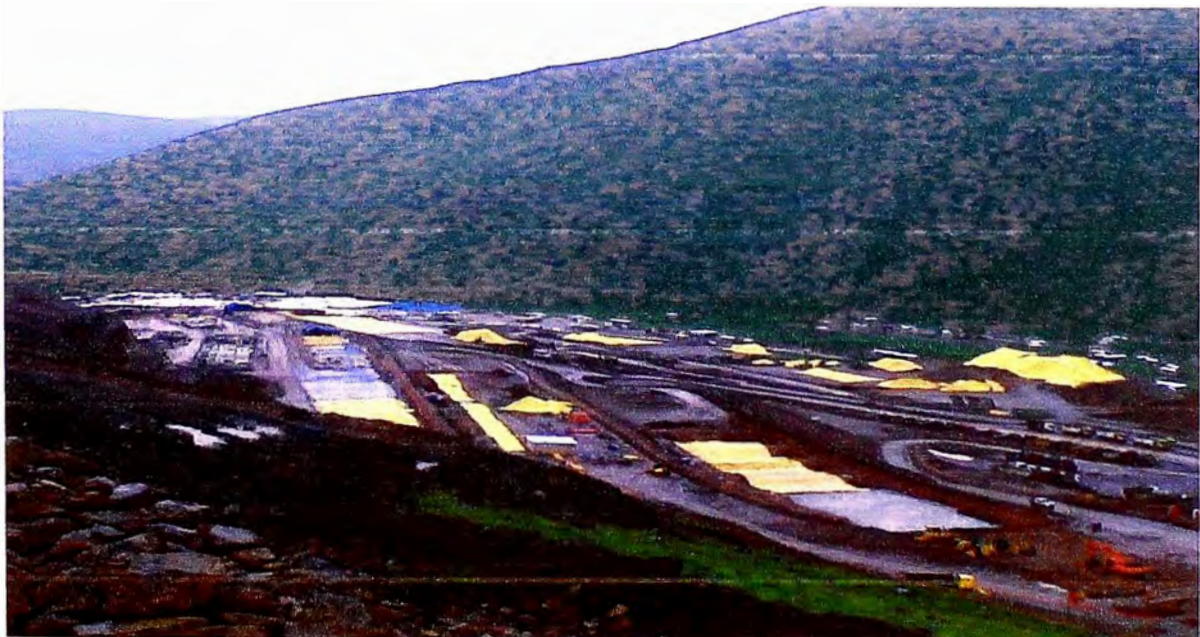
Foto 15. Plataformas 1, 2 y 3 con rellenos de ingeniería terminados.
