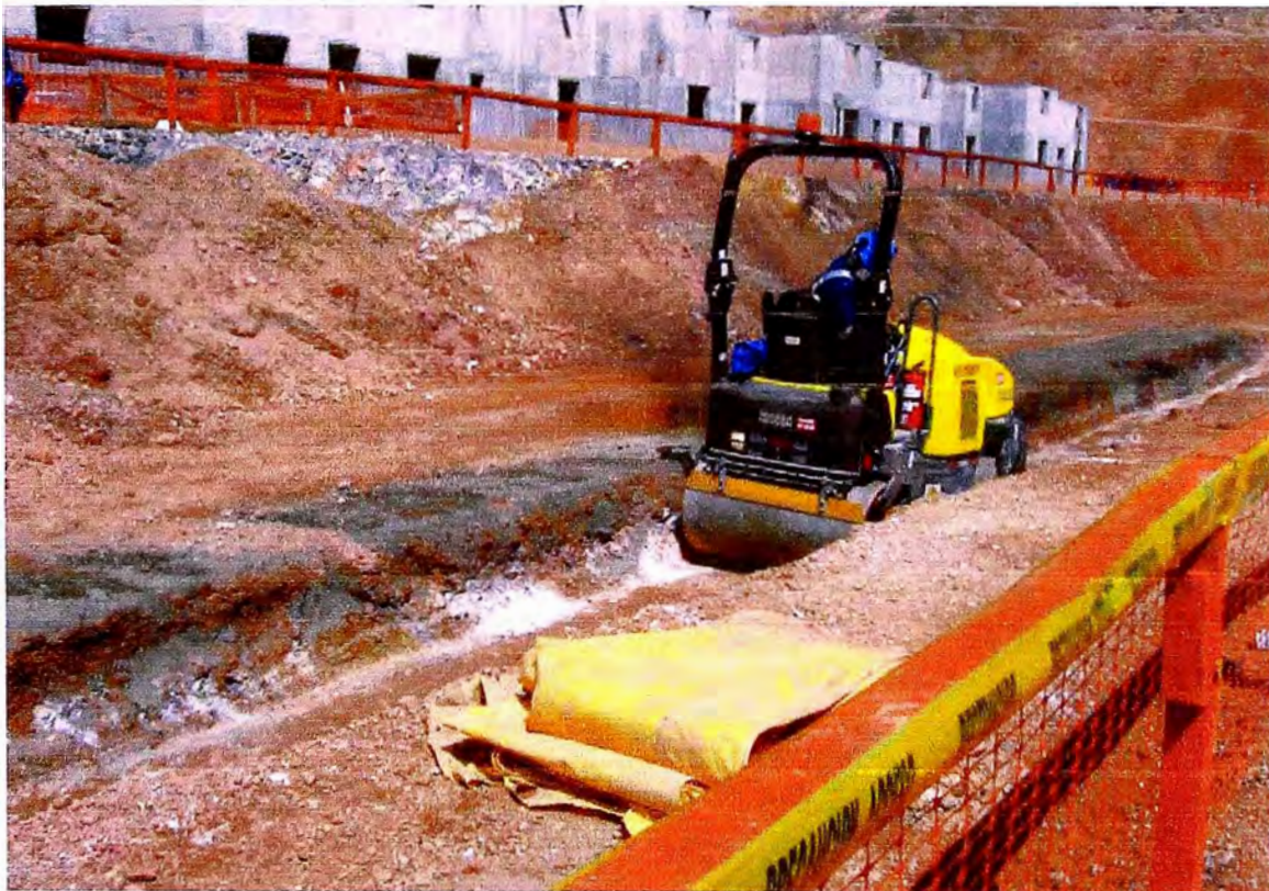
Foto 1. Compactación de última capa en terreno suelto. Manzana "O" Proyecto NFB.
