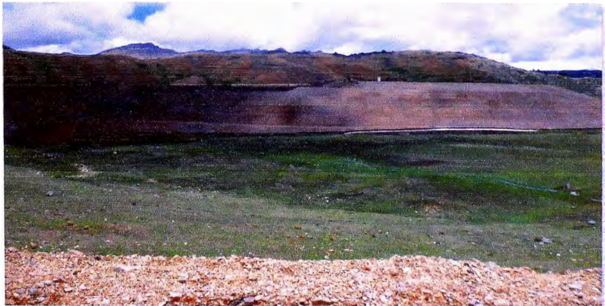
Foto 8. Trabajos de remediación del DME-10
