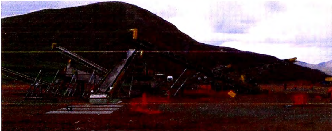
Foto 20. Planta de agregados para operaciones de UNICON.
