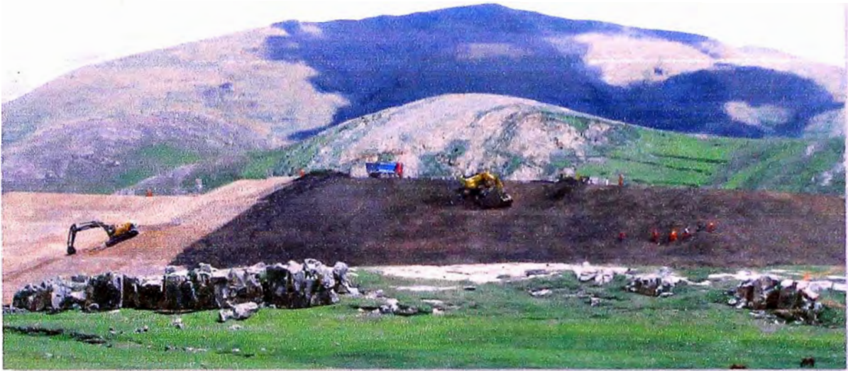
Foto 9. Perfilado de taludes y banquetas DME-10.
