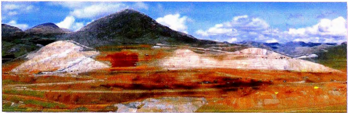
Foto 4. Excavación completa del plataformado para la ciudad Nueva Fuerabamba.
