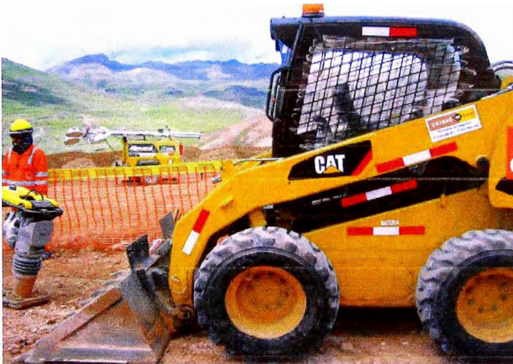
Foto 6. Minicargador para eliminación de material excedente a punto de acopio.
