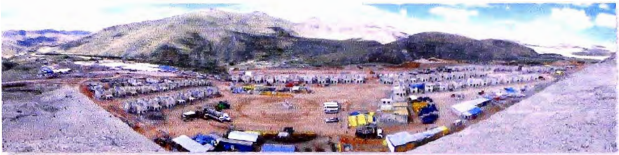
Foto 11. Vista Panorámica de la construcción de viviendas en la parte alta.
