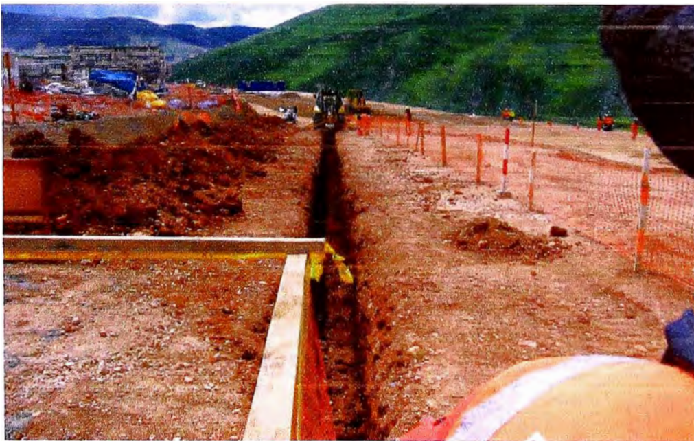
Foto 7. Excavación de zanja con retroexcavadora en material suelto.
