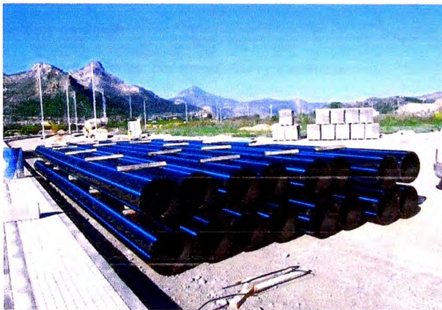
Figura. 2.10.3. "Tramos de Tubería HDPE almacén Cuzco Fbamba"
