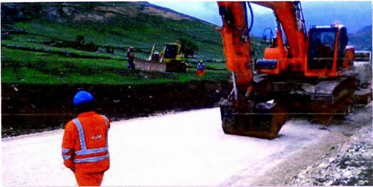
Foto 5. Construcción de acceso Sur a la Ciudad Nueva Fuerabamba.
