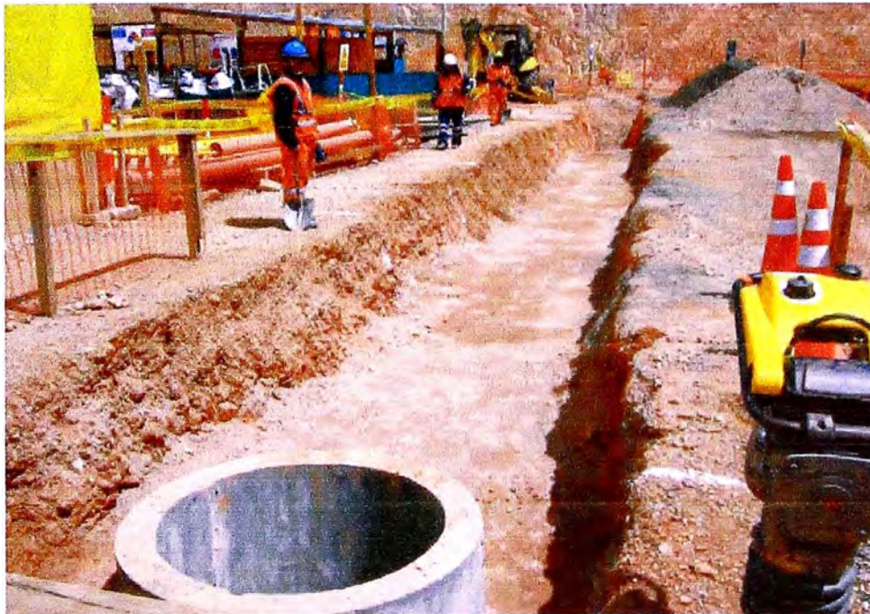
Foto 2. Penúltima capa compactada con vibro apisonador en terreno rocos. Mz "P" Proyecto NFB.
