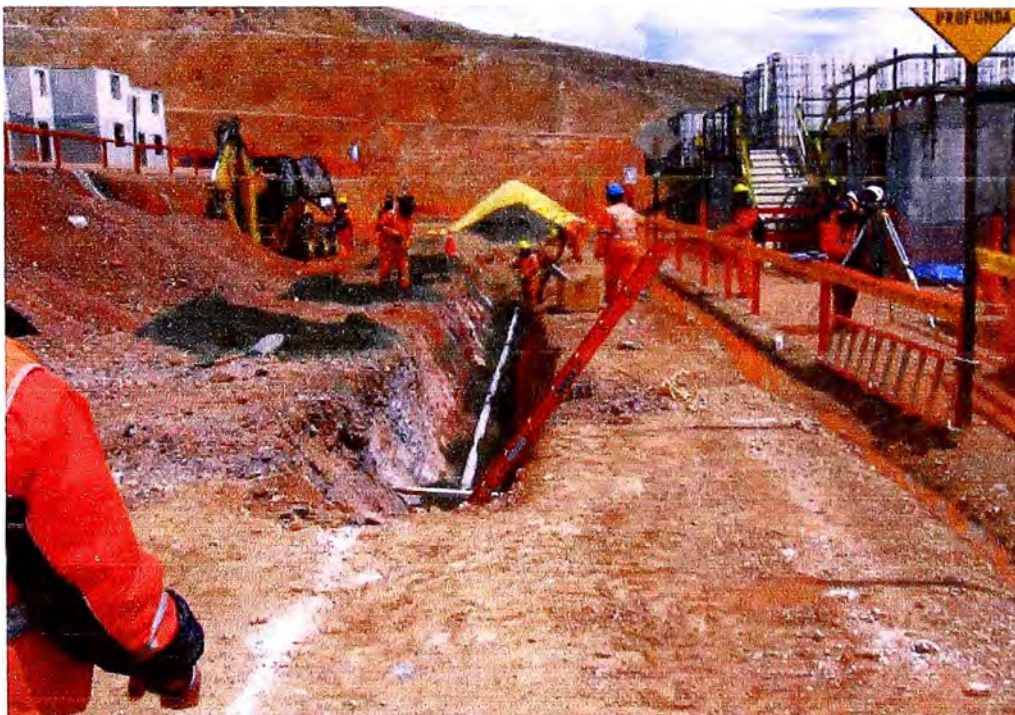
Foto 3. Tendido de tubería de agua en terreno suelto. Manzana "O" Proyecto NFB.
