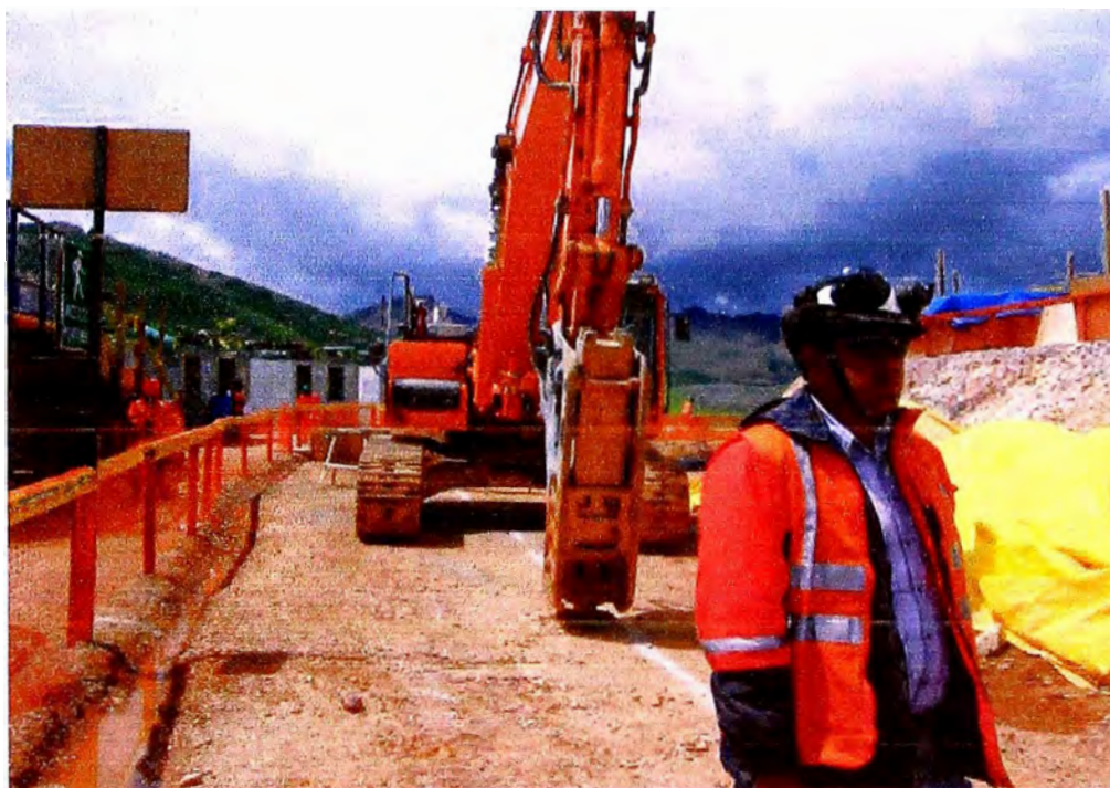
Foto 4. Fracturación de roca para excavación de zanja. Manzana "P" proyecto NFB.
