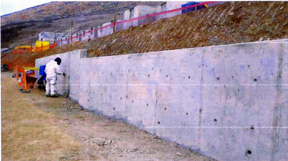
Foto 16. Limpieza de muros de contención en la plataforma 2.
