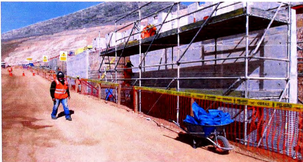
Foto 17. Limpieza de muros de contención en plataforma 2. Paños intercalados.
