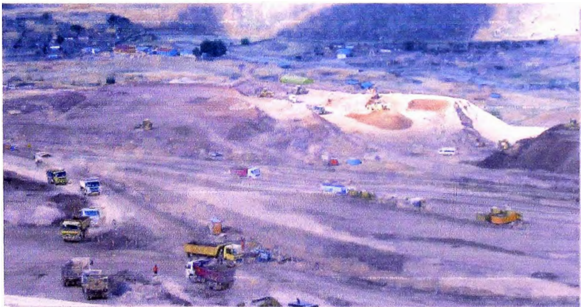
Foto 10. Operaciones en la ciudad Nueva Fuerabamba.
