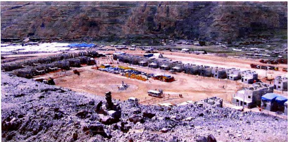
Foto 13. Vista Panorámica de la construcción de viviendas en manzanas P y M.
