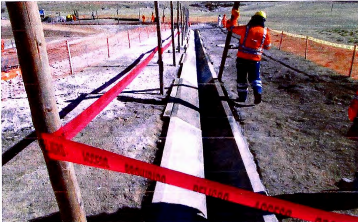
Foto 18. Cuneta triangular para drenaje pluvial.
