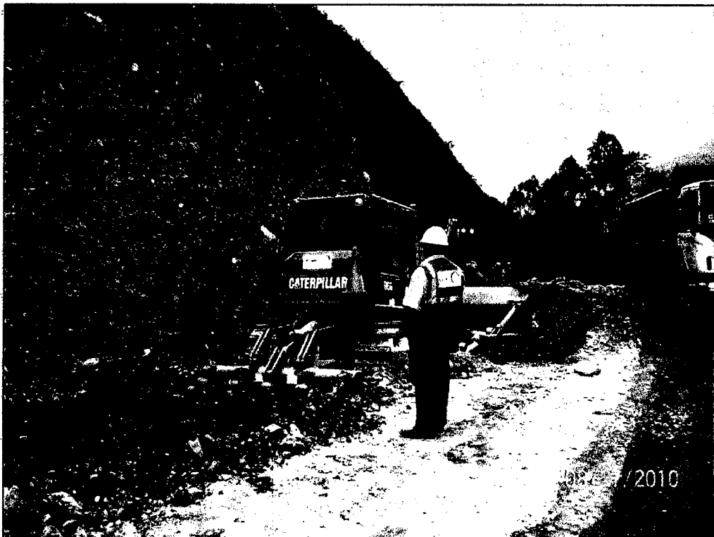
Figura 3.54. Tractor Oruga D6G cortando plataforma, Excavadora CAT 336DL eliminando material excedente, km 96+360.
