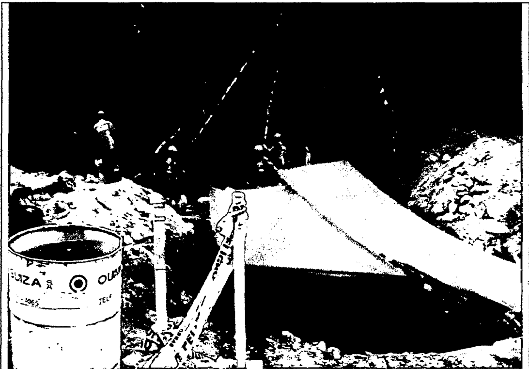
Habilitación de cobertores sobre el área de trabajo, para poder continuar con las labores.
