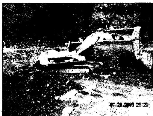
Figura 3.52. Excavadora CAT 330DL, Cortando plataforma, km 88+010.
