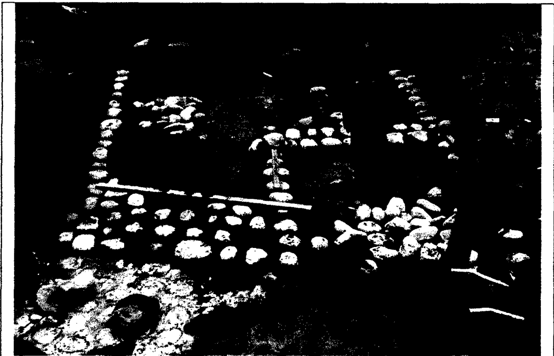
Emboquillado y nivelado de piedras, colocación de piedras sobre mezcla de concreto.
