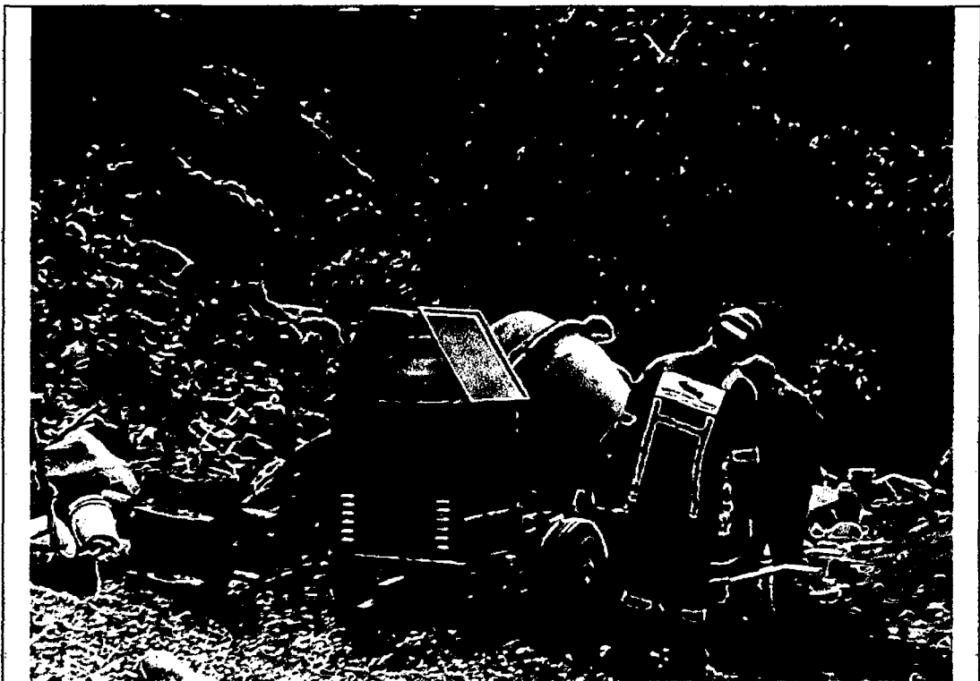
Preparación de Mezcla, 2 obreros; 1 peón para llevar carretilla, y el peón que maneja el trompo.
