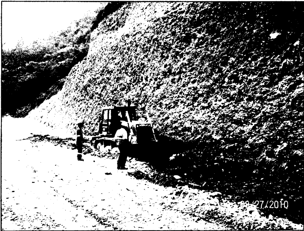
Figura 3.55. Tractor Oruga D6G, Corte de plataforma, km 96+380.
