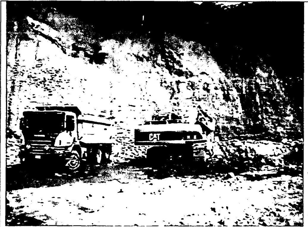
Excavadora extrayendo material, con altura de banco=0 y ángulo de carguío de 95°.
