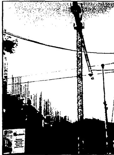
Figura N°4.14: Grúa torre instalada
