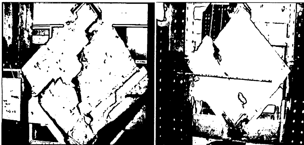
3) Falla de corte diagonal en bloques y juntas
