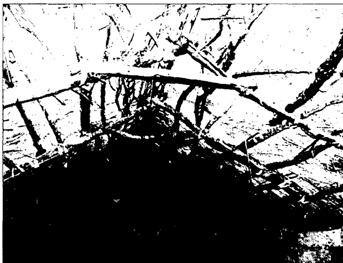
Figura N°3.15: Estructura interna de la vivienda de adobe con techo de madera rolliza y cobertura de paja (comunidad Pujio Pujio).
