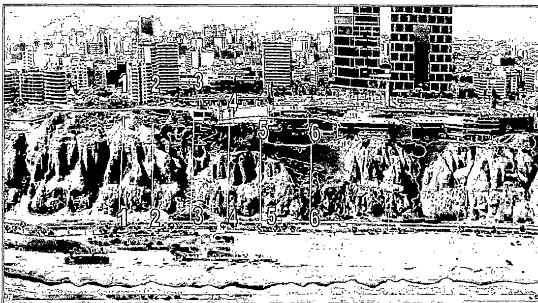
Figura 4.5: Vista Panorámica de la ubicación de las Secciones (Fuente de Imagen Caretas, Febrero 2008)
