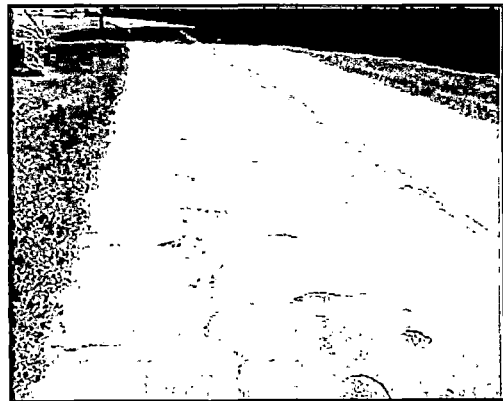
Foto N° 4.21: Desprendimiento de los agregados severidad baja y severidad alta 95
