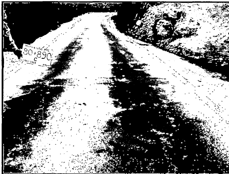
Foto N° 4.2: Exudación de asfalto en Tratamiento Superficial Monocapa, severidad Media 77
