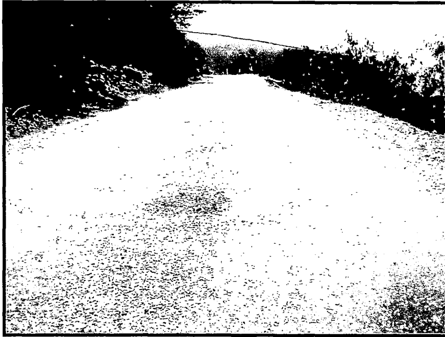
Foto 3.5: Tratamiento superficial Monocapa después de barrido del excedente de gravilla 66
