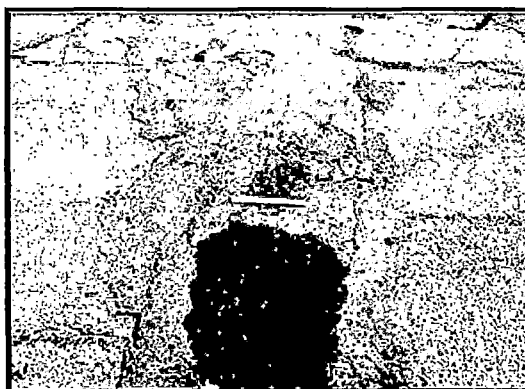
Foto N° 4.15: Parches severidad baja y severidad alta 89 .
