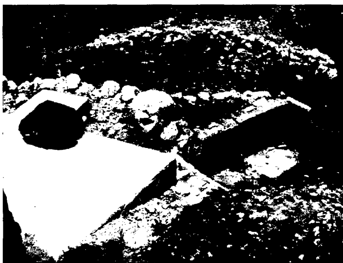
Foto Nro. 4.2: Captación Manantial Yuraccunya, vista de la poza existente que se usó para el aforo
