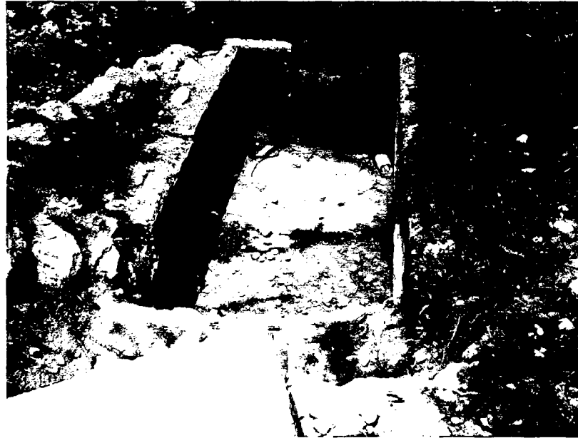
Foto Nro. 4.5: Captación Yuraccunya, Poza deteriorada de concreto para aforo de captación.
