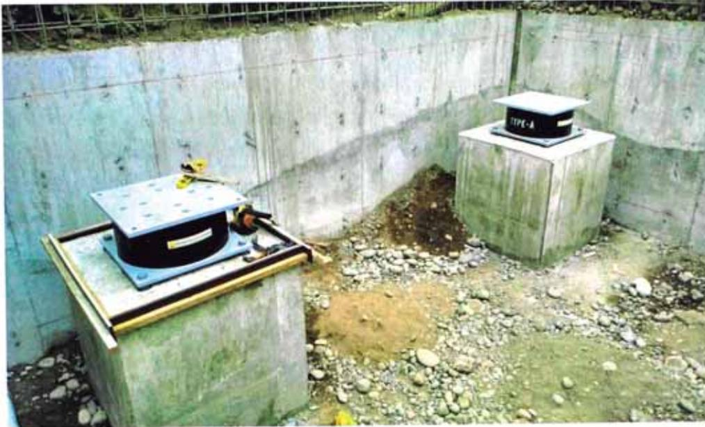
Figura N° 3.7 Instalación de Aisladores sísmicos en pedestales
