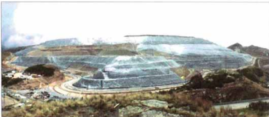
Figura N° 2.6: Disposición de la cobertura impermeable
