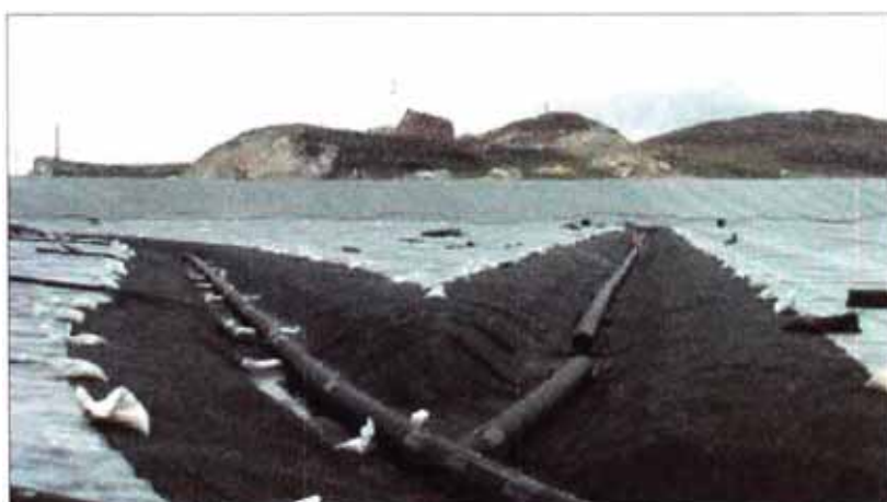
Figura N° 2.2: Construcción del sistema de colección de solución
