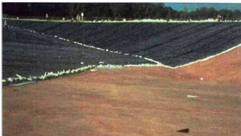
Figura N° 2.1: Revestimiento de la plataforma de lixiviación
