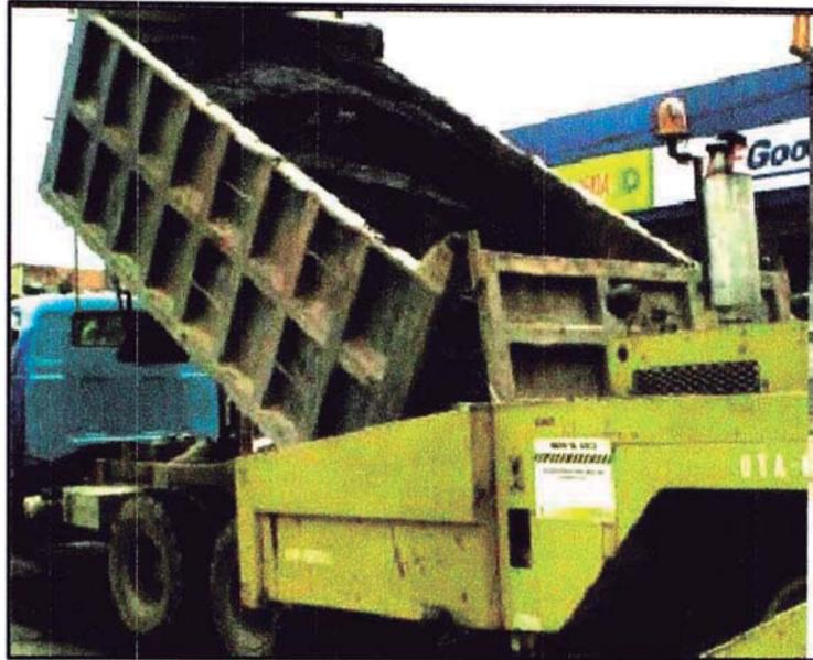
Figura N° 4.8.- Descargue del asfalto a la pavimentadora.
