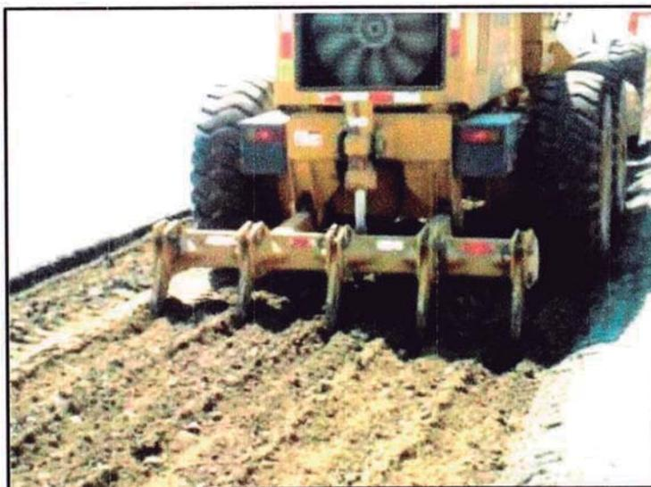
Figura N° 4.1.- Escarificación de la superficie de la subrasante.
