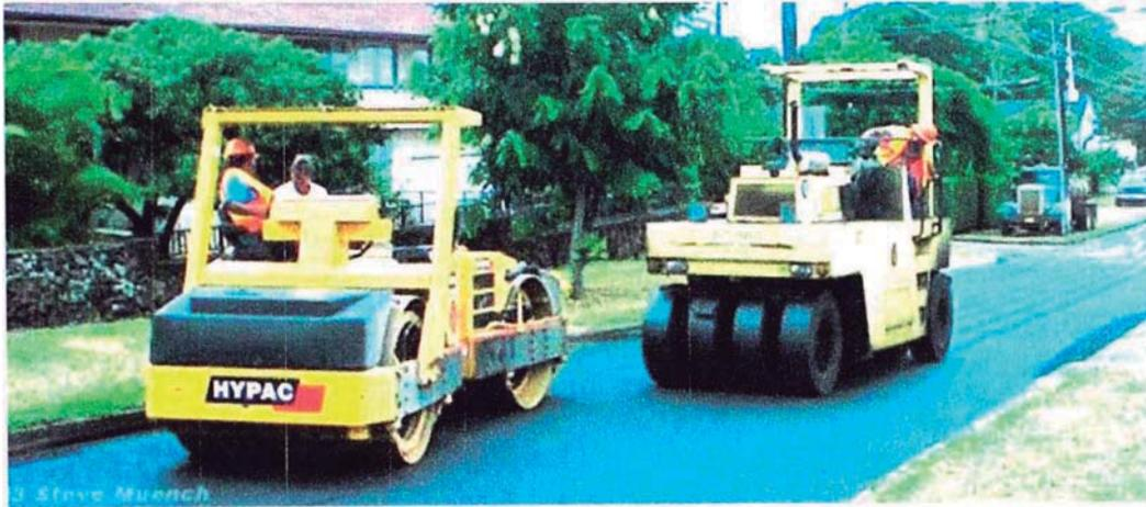
Figura N° 4.10.- Compactación de la carpeta asfáltica.
