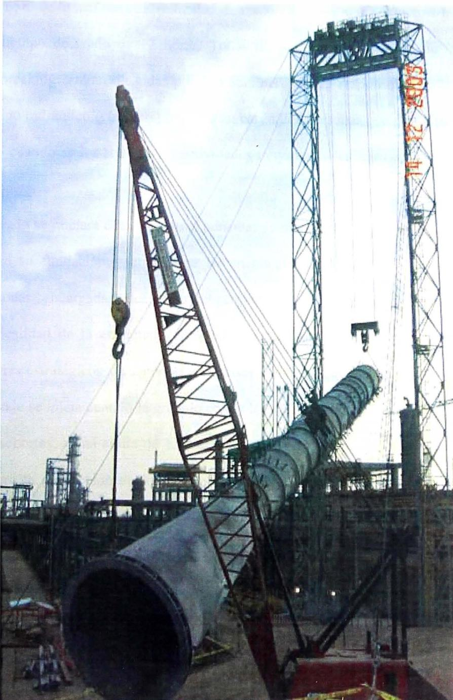
Figura 6.9 Verticalización columna visbreaking
