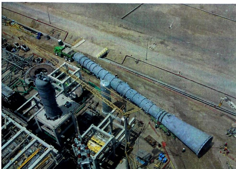
Figura 6.7 Llegada columna Visbreaking a obra
