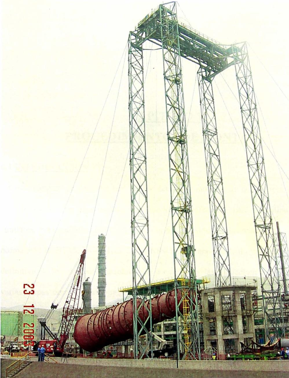
Figura 5.5 Torre de izaje instalada
