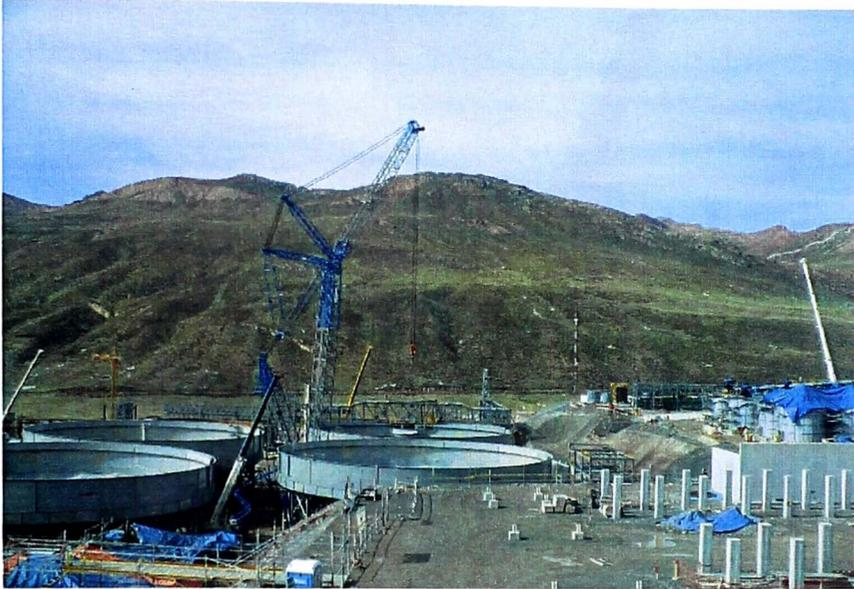
**Figura 13: Montaje de barcaza para bombeo agua de relaves**
