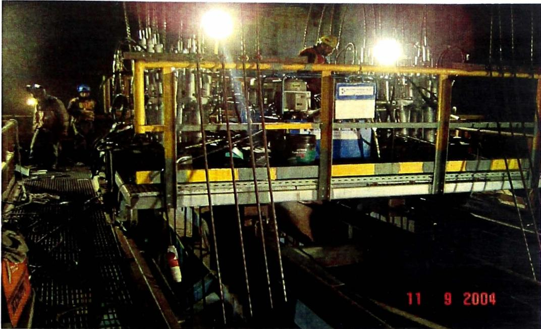
Figura 4.5 Gatos hidráulicos en operación
