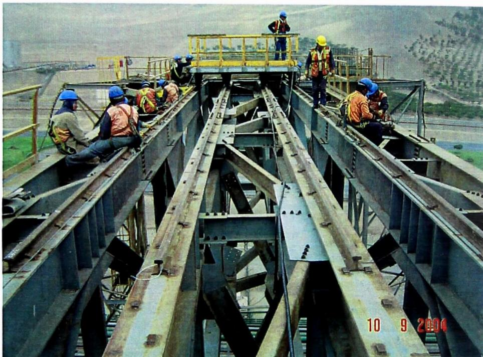
Figura 5.2.3.- Montaje viga de apoyo y gancho
