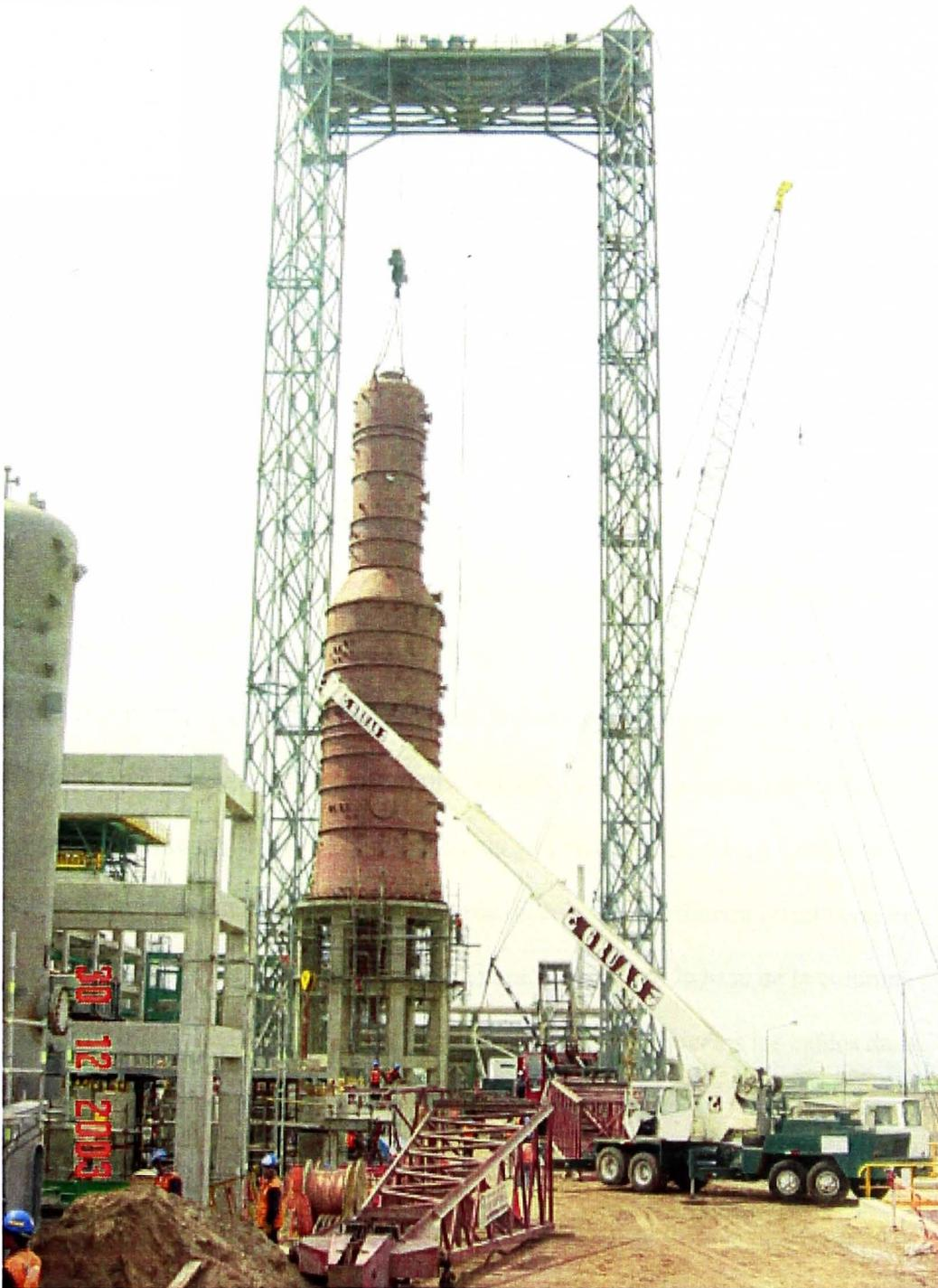
Figura 6.5 Montaje sobre fundación
