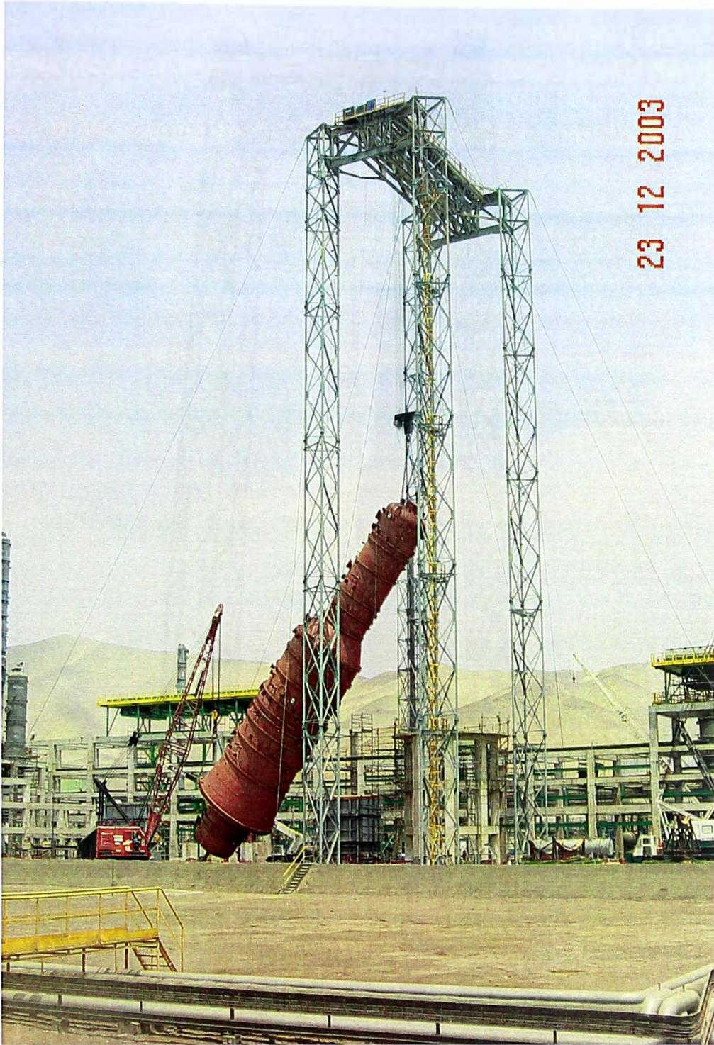
Figura 6.3 Verticalización del equipo
