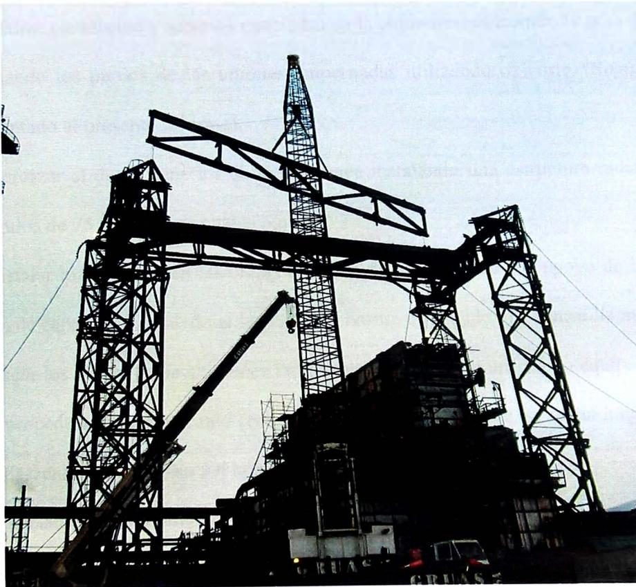
Figura 6.11 Montaje de estructura torre de izaje
