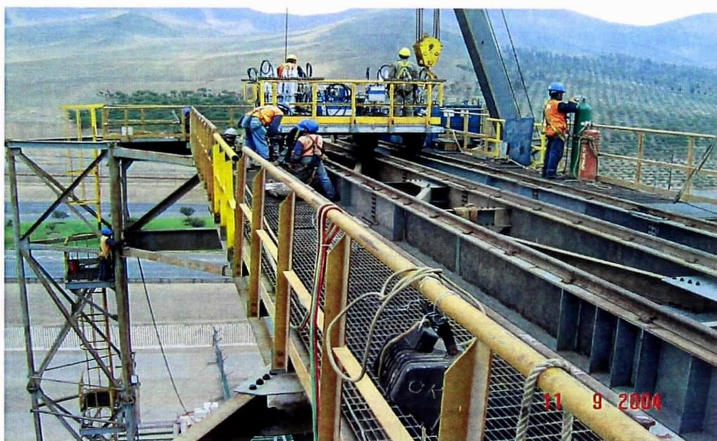
Figura 4.4 Montaje de gatos hidráulicos sobre torre de izaje
