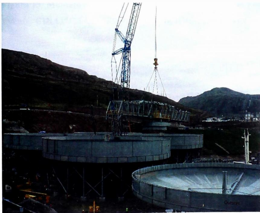
Maniobra de montaje casco y puente con grúa 600 Ton
