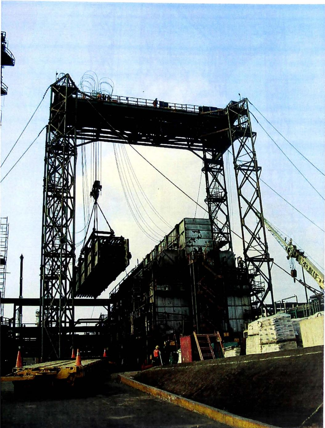
Figura 6.12 Desmontaje de módulos de convección
