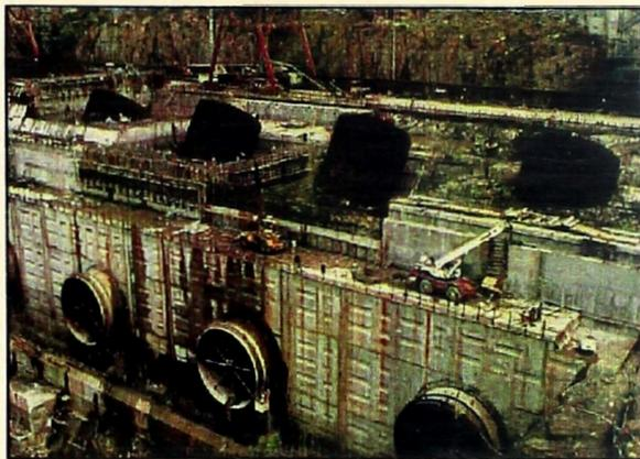
Ensamble en sitio de 72 Virolas (peso: 4,500 ton) para Tubería Forzada (en la fotografía, ya instaladas), EDELCA, Central Hidroeléctrica Macagua II, Año 1988-90.
