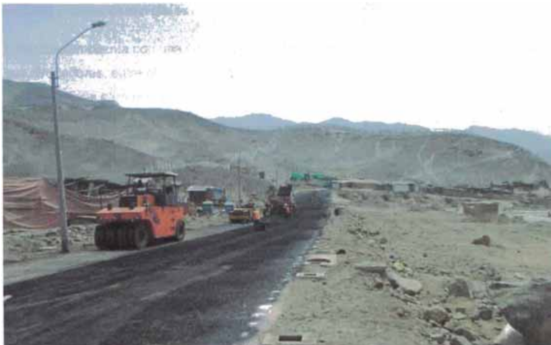
Figura 1.4: Asfaltado de la calle 08 en Villa Club 05.(Fuente : Proyecto Villa Club 05).
