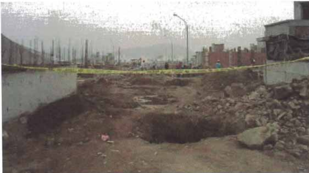
Figura 3.14: Los accesos bloqueados por las conexiones de agua potable cuya ejecución se encuentra inconclusa. (Fuente propia).
