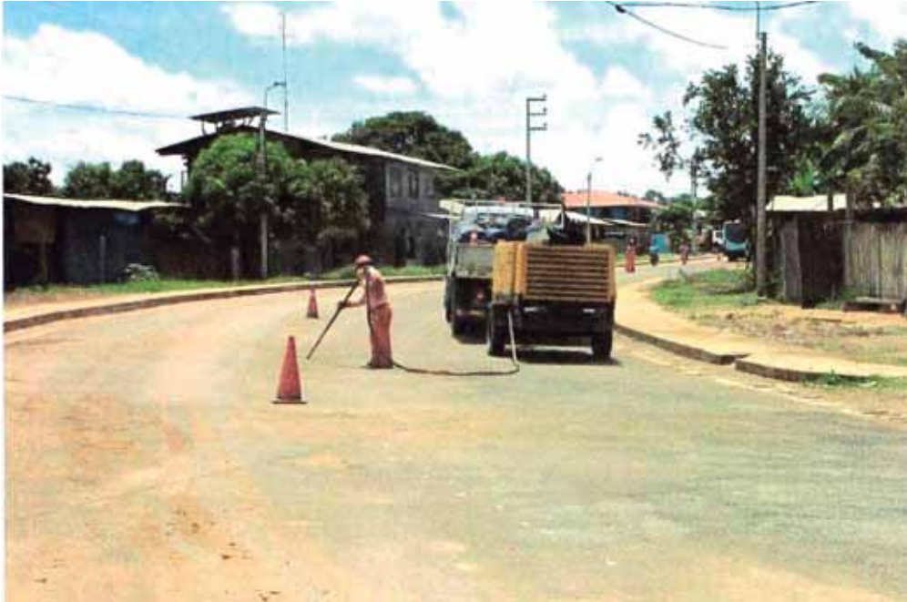
Foto 3.2: Utilización de la compresora (Depende de las impurezas en el sector)
