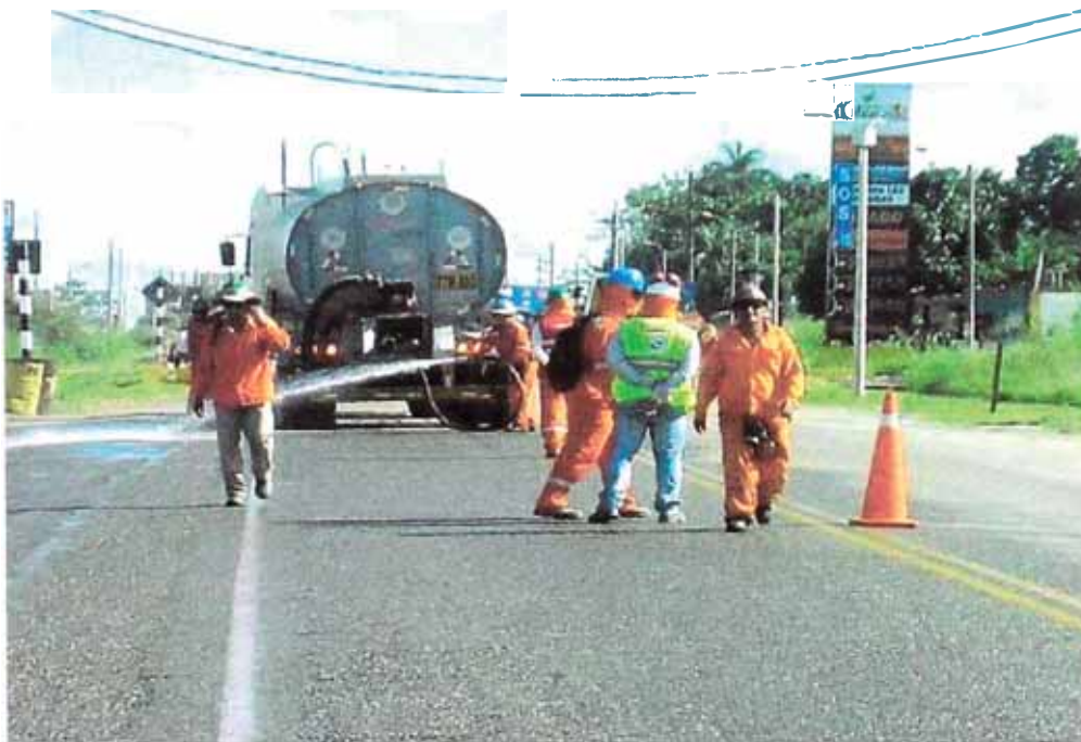
Foto 3.3 Limpieza de la superficie a aplicar el micropavimento.
