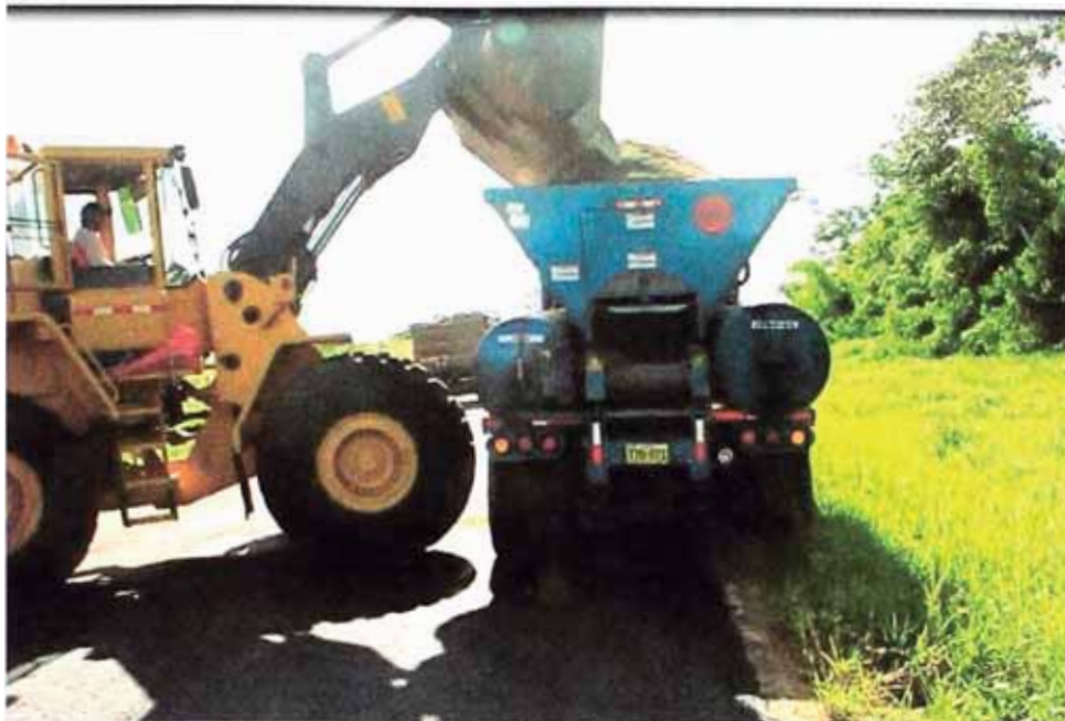
Foto 3.6: Colocación de agregado en la micropavimentadora con el cargador
