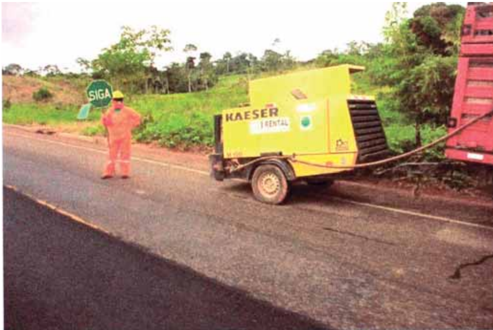
Foto 3.1 : Traslado de la compresora para limpieza de superficie
