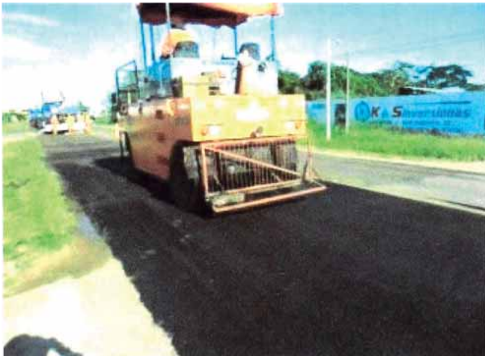
Foto 3.11 Compactación de la superficie con rodillo neumático
