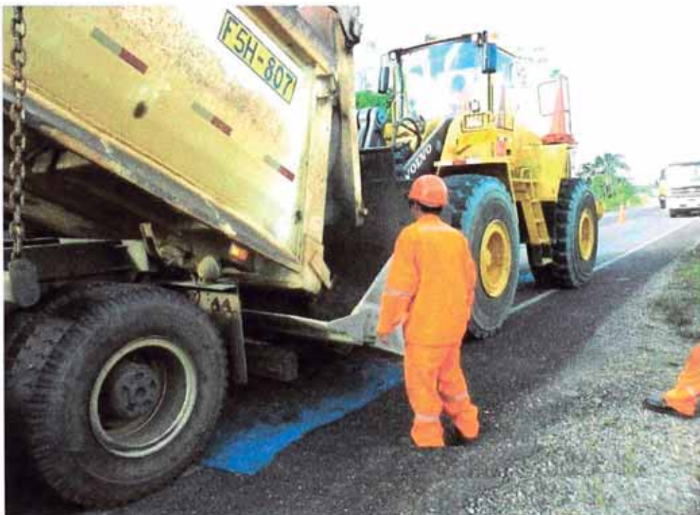
Foto 3.5: Traspaso de agregado del volquete hacia el cargador
