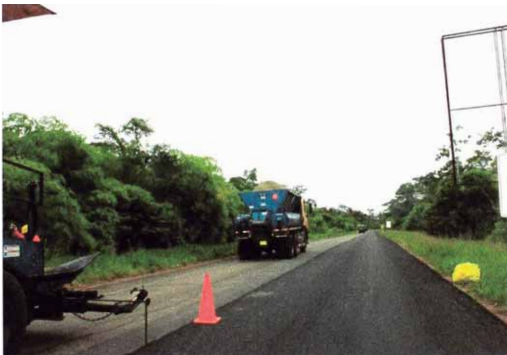
Foto 3.7: En la micropavimentadora ocurre la mezcla de la emulsión con el agregado
