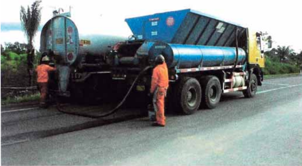
Foto 3.4: Vaciado de la emulsión de la cisterna hacia la micropavimentadora
