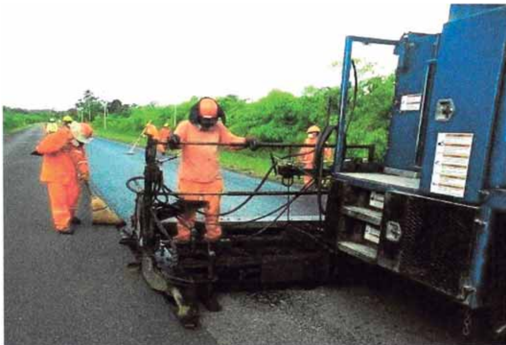
Foto 3.9: Aplicación del micropavimento
