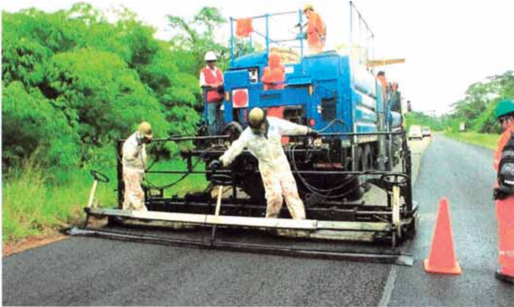
Foto 3.8: Verificación del espesor graduado en la micropavimentadora
