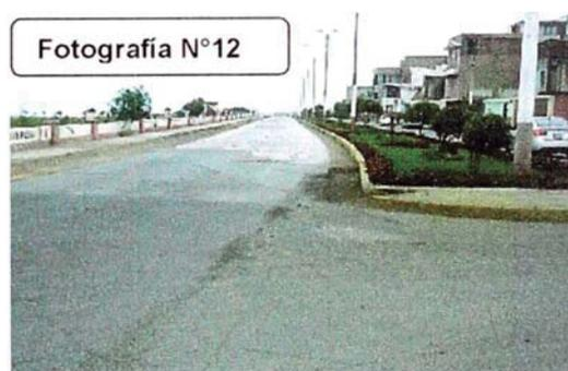
El pavimento y las veredas son de concreto, las bermas laterales son de terreno natural, la berma central está definida por sardineles y cuenta con área verde con relativo mantenimiento. Hacia el acantilado existen elementos de protección del tipo muretes.
