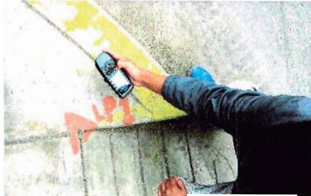
Fotografía N°17: Punto geodésico LP 1 de la poligonal de apoyo
