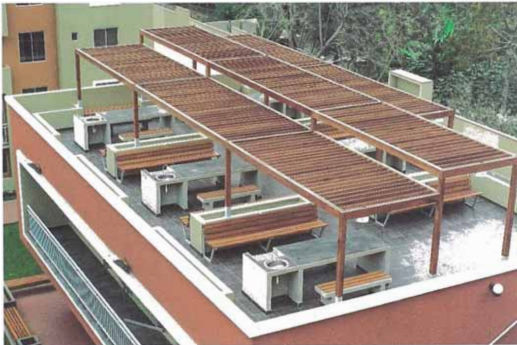
Figura 3.5 Zona de Parrillas
