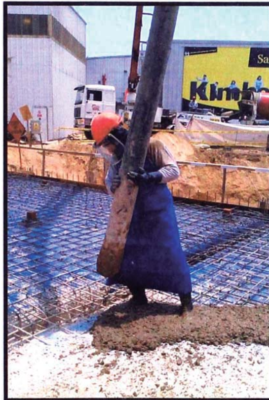
Figura 10: Vaciado de concreto en la losa maciza
