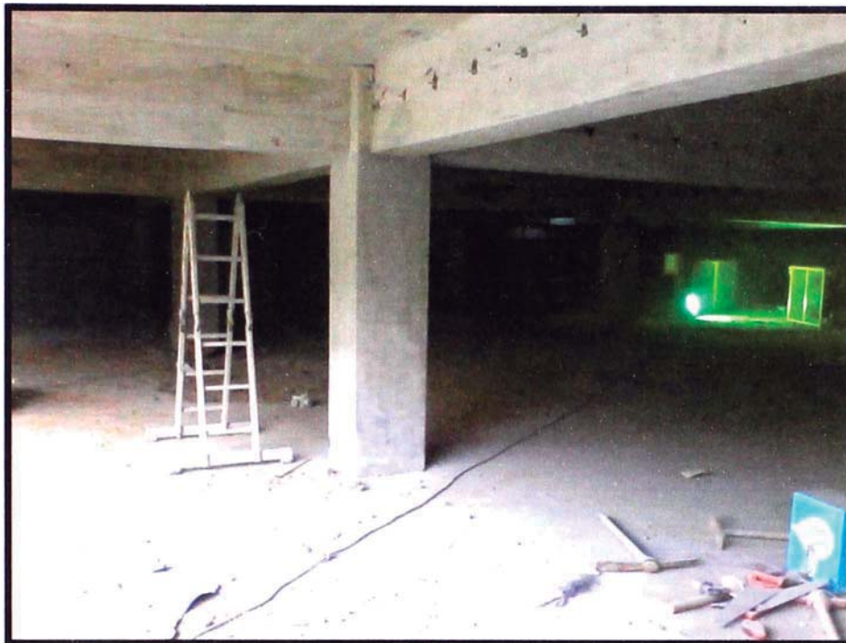
Figura 8: Encuentro de Vigas y Columnas
