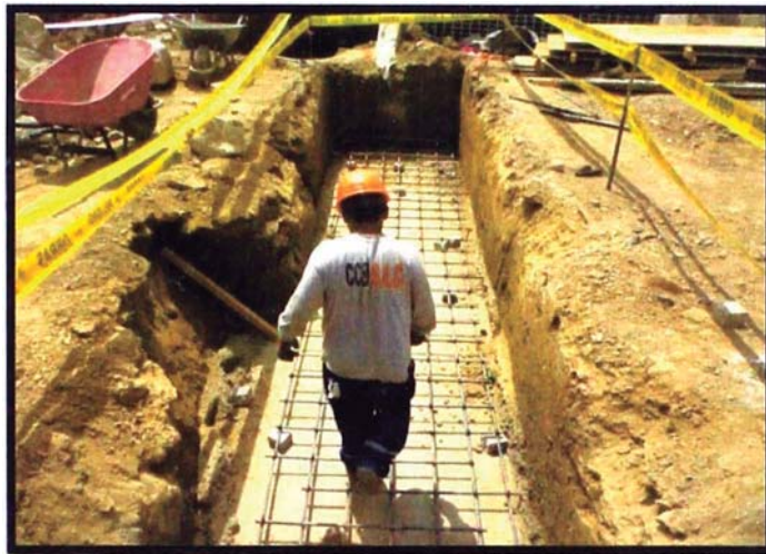
Figura 3: Cimentación de la placa
