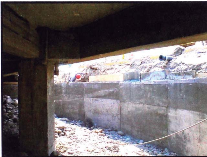
Figura 6: Muro de contención perimetral
