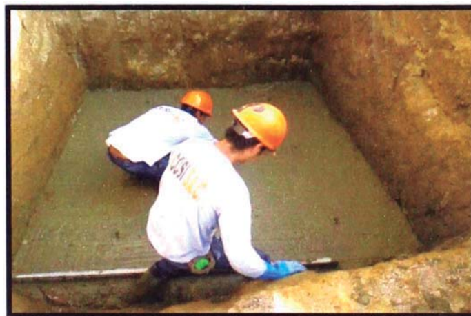
Figura 4: Solado de zapata típica
