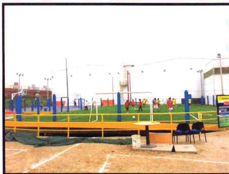
Figura 11: Campo deportivo sobre la cisterna contra incendios
