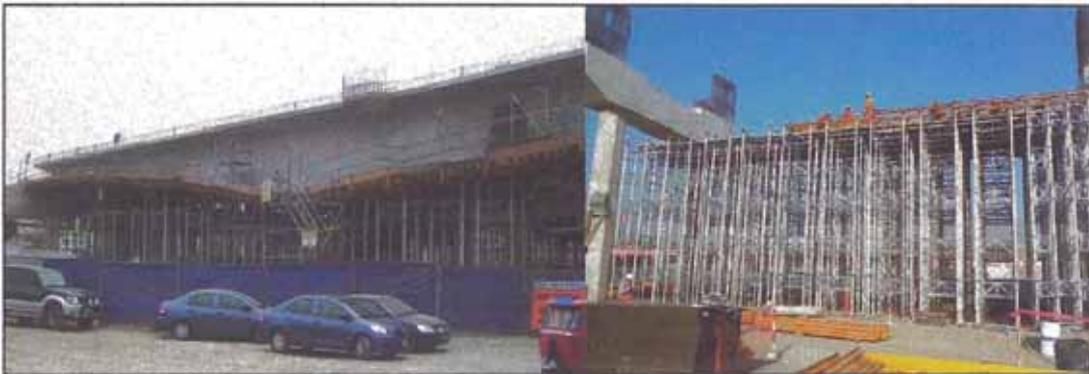
Figura N°2.7.-Torres Aluprop como soporte del encofrado horizontal- Tren Eléctrico.
