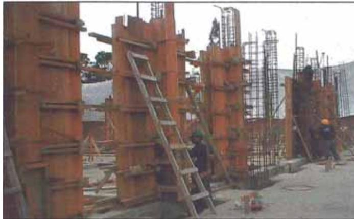
**Figura N°1.3.- Encofrado tradicional de columnas a base de madera.**
