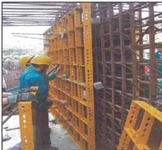
**Figura N°2.2.- Sistema manuportable COMAIN.**
