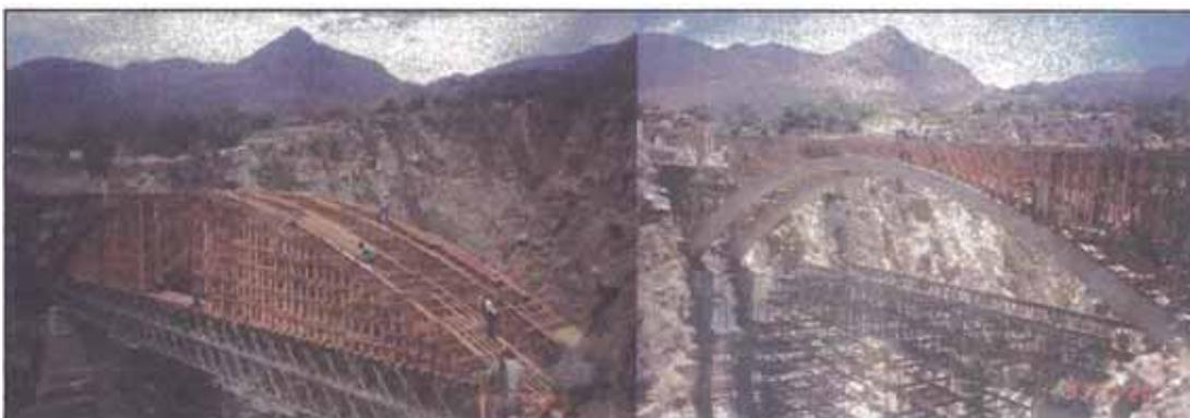
Figura N°1.11.- Soporte y encofrado de madera del puente "Tsejtsi"- Huancavelica (Perú).
