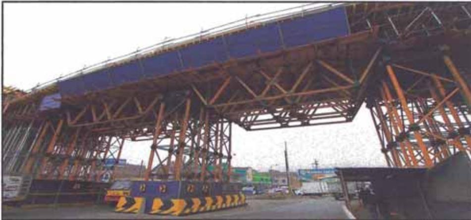
Figura N°1.5.- Falso Puente del puente Santa Rosa- Proyecto Tren Eléctrico (Lima-Perú).
