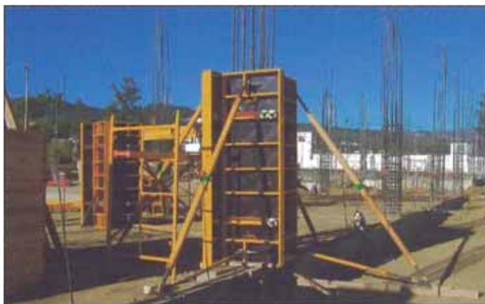
**Figura N°1.4.- Encofrado modular de columnas a base de paneles metálicos.**
