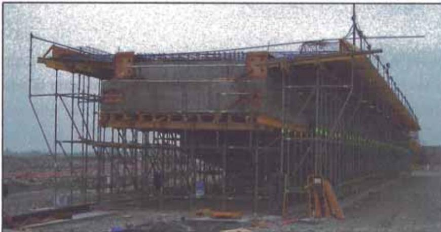
Figura N°2.3.-Sistema BRIO como cimbra de apeo del encofrado.
