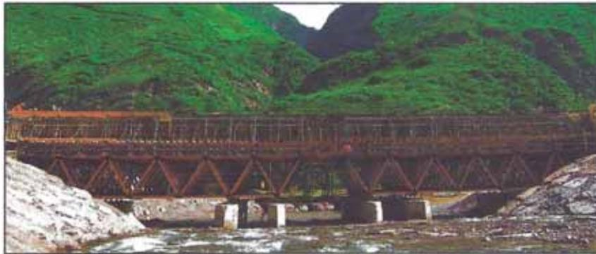
Figura N°1.15.- Falso puente de cercha metálica del puente Tingo – Amazonas (Perú).
