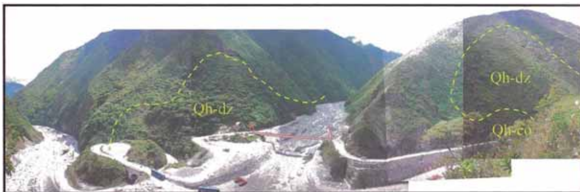
Figura 3.7: Vista de depósitos de Deslizamiento en ambos Márgenes.
