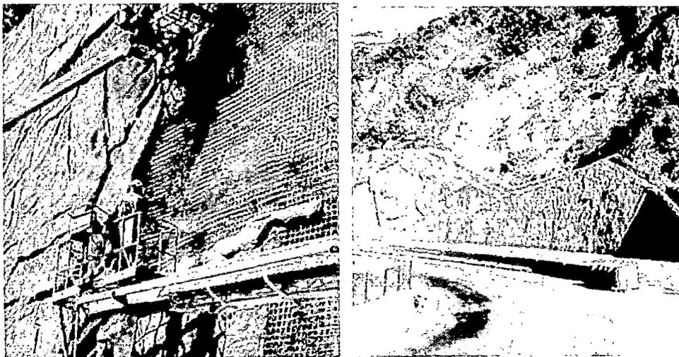
Fig. 1.9 Utilización del shotcrete en estabilización de taludes en California
