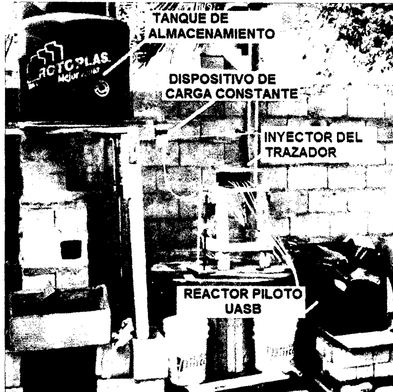
Figura III.38.- Ubicación del Inyección de Trazador en la Planta Piloto
