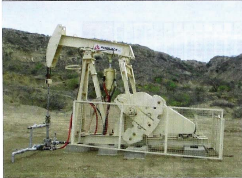
Fig. A-12: Instalación completa de un compresor de viga balancín
