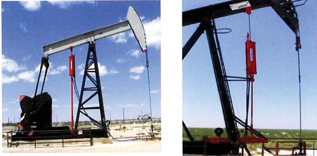
Figura A-07: Posiciones del CGB en la unidad de Bombeo Mecánico
