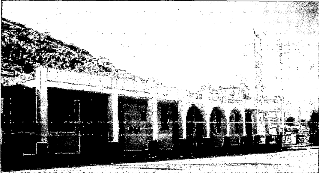
Local Comunal, Barrio Centro
