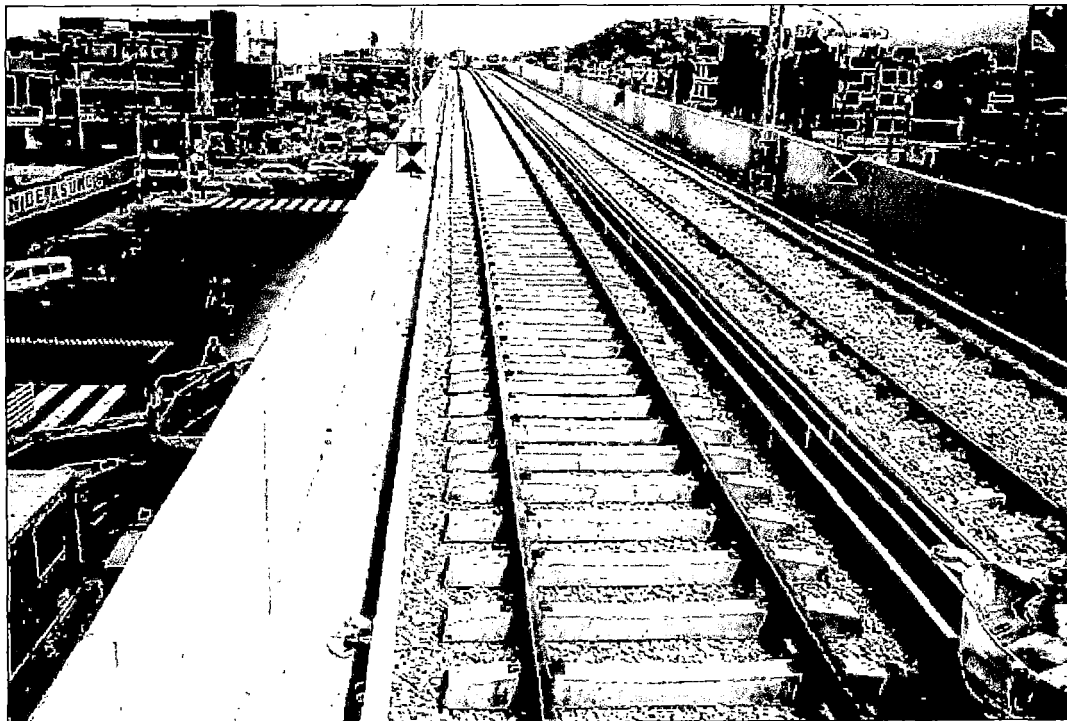
Vista de la construcción del viaducto elevado de la Línea 1, en San Borja
