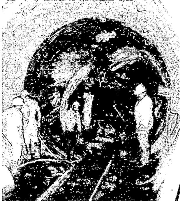
**Figura N° 90:** Excavación del remanente de la TBM atrapada en el TúnelYacambu-Quibor en Venezuela, [32]
