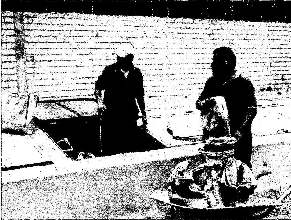
Foto N° 1.- Sacando Agregados de la Tolva
