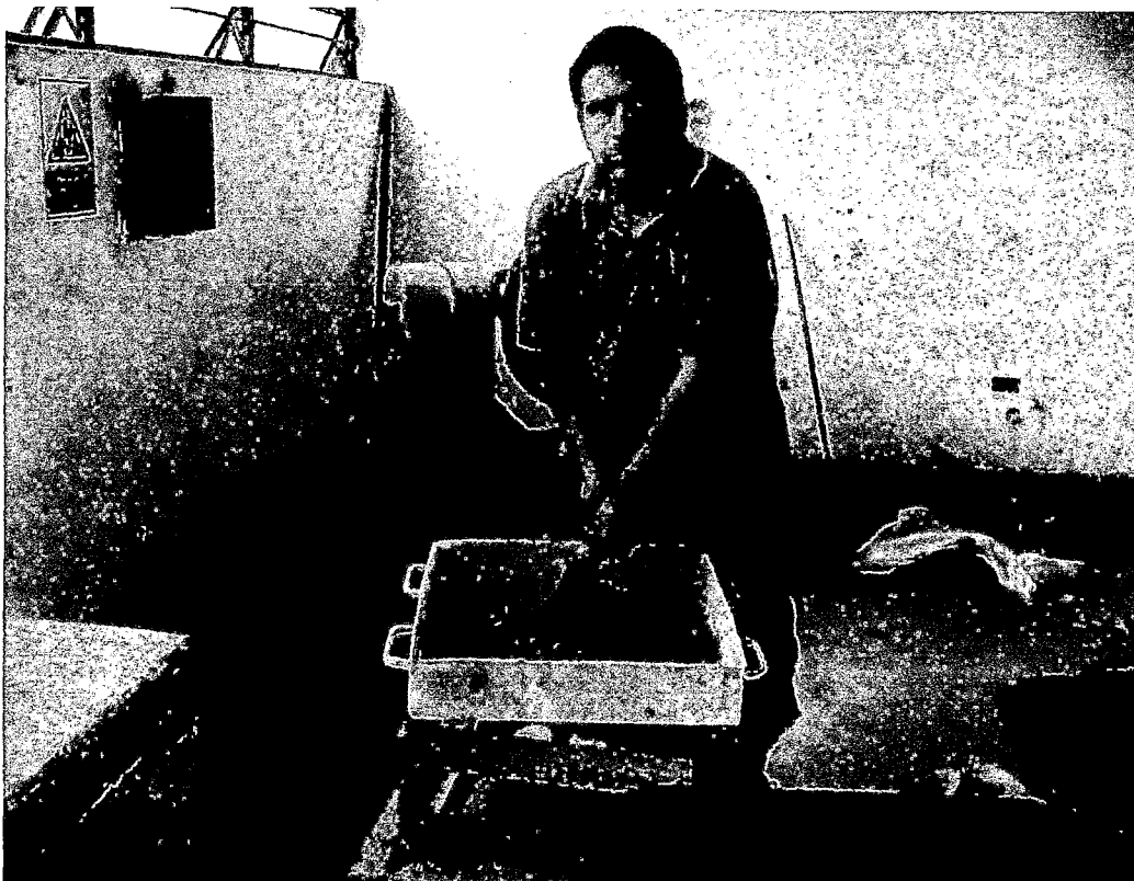
Foto N° 13.- Mezcla para el fraguado en la máquina vibradora.
