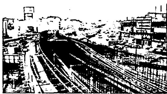
11. Acero y encofrado de losa de piso y paredes de Viga Cajon
