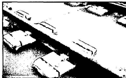
Vaciado de concreto ejecutado
