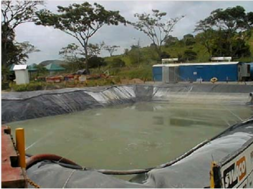
Fig. 3.13 Sistema de Piscinas
