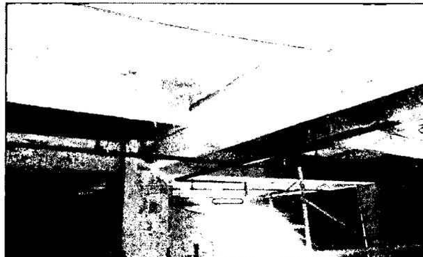
*Figura 3.6: Interferencia entre tuberías de agua contra incendio con ductos de extracción de monóxido*
