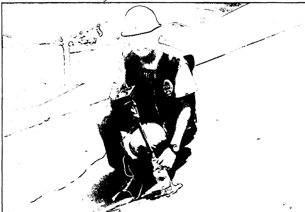
Fig. 6.58: Medición de la diferencia de potencial en el cascaron de la estructura.
