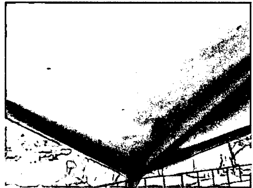
Fig. 6.17: Descascaramiento del concreto por la corrosión.
