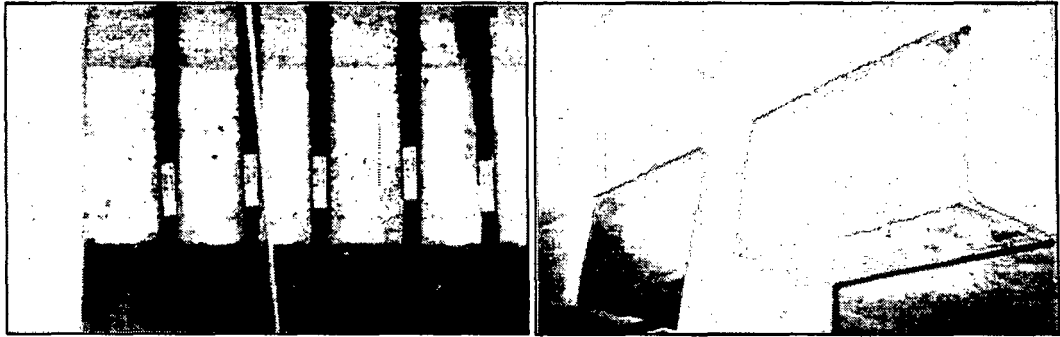
Fig. 4.31: Refuerzo de vigas a cortante mediante a) láminas de carbono y b) fibras de carbono. (Sika.com.pe)
