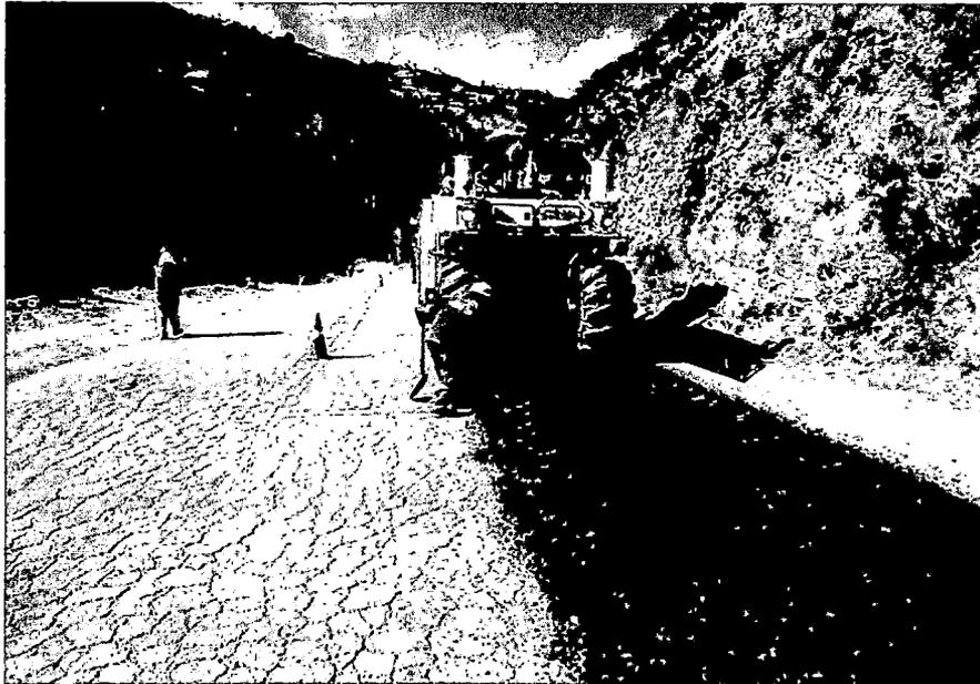
Figura N° 5. 1 Muestras obtenidas inmediatamente después del paso de la máquina recicladora.
