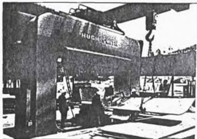
Fig. 9 Prensas tipo pórtico efectuando rolados.
