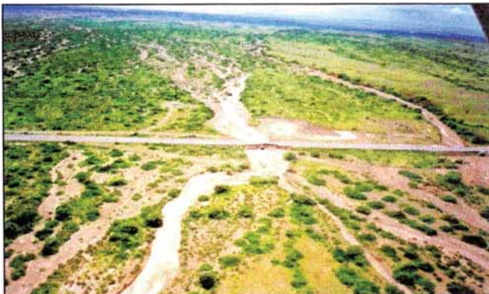
Foto N° 4.4 Socavación local del lecho del cauce, aguas debajo de la alcantarilla. Se observa el efecto de socavación del cauce por falta de colchón dissipador de energía y en consecuencia, se produjo el colapso de los cabezales a la salida de la obra de cruce.
