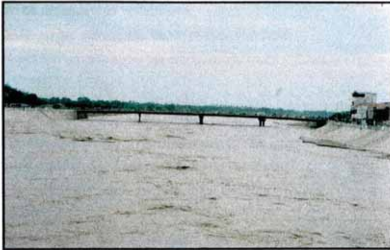
Foto N° 6.10: Puente Bolognesi, caudal de 3000 m 3 /s (marzo 1998)
