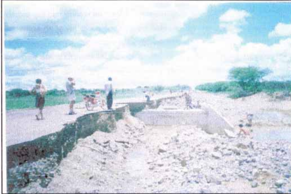
Foto N° 4.4 Socavación local del lecho del cauce, aguas debajo de la alcantarilla. Se observa el efecto de socavación del cauce por falta de colchón dissipador de energía y en consecuencia, se produjo el colapso de los cabezales a la salida de la obra de cruce.
