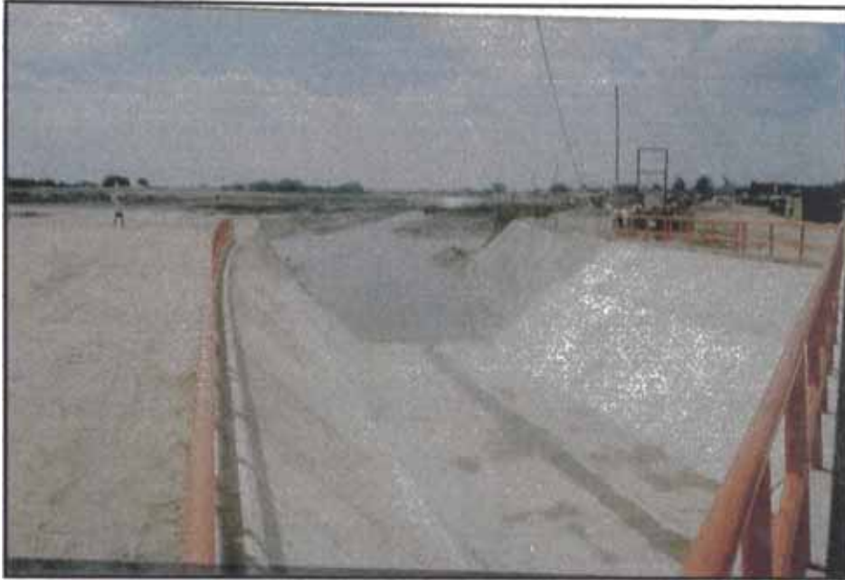
Foto N° 6.2: Desembocadura del dren Sullana en la Laguna Azul.
