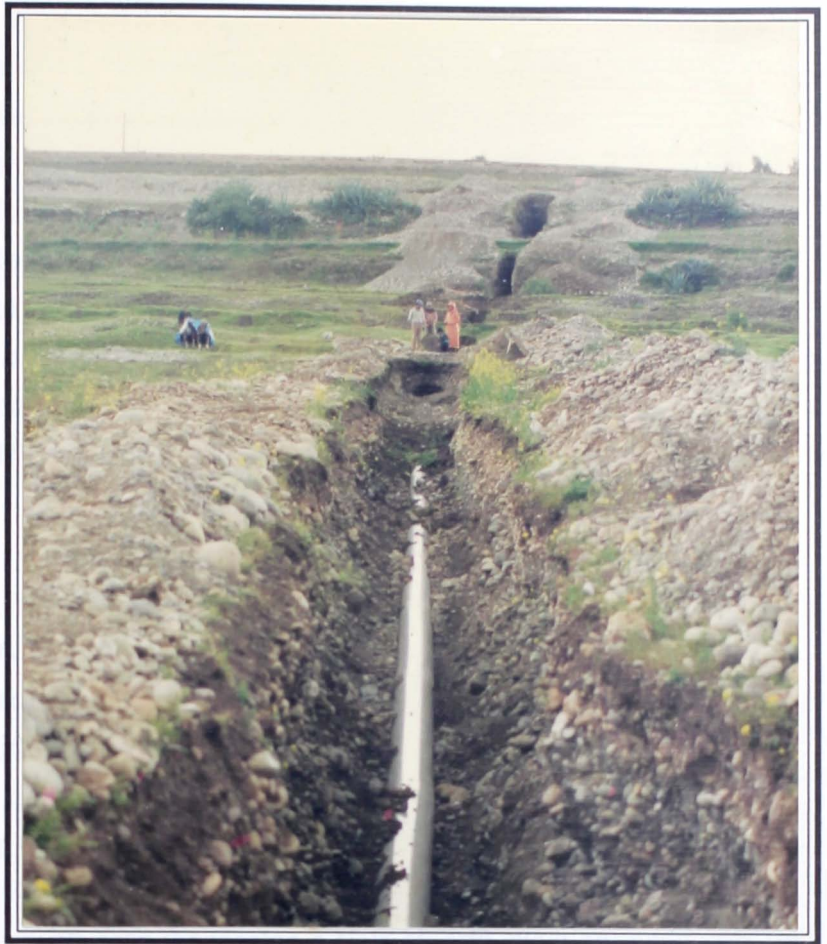
Foto 1: Una vista panoramica donde se observa el eje del tendido del nuevo colector E-3 a una profundidad de 2,5m. en promedio. En el se puede ver el predominio del material gravoso con piedras de hasta 3". Esta vista corresponde a la zona de expansión SE de la ciudad entre el Aeropuerto y la linea del ferrocarril.
