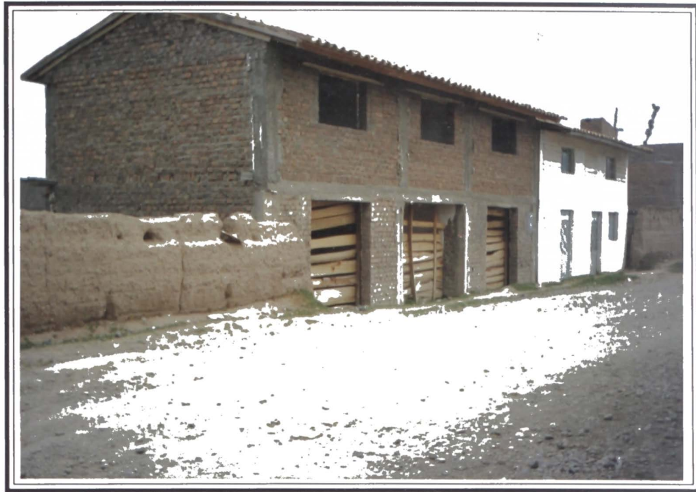
Foto 3: Vista lateral y frontal de una edificación en el que se observan los muros de confinamiento que son muy amplios entre columnas, sin vigas de confinamiento con dinteles y entrepiso de madera, con techo pesado de tejas de arcilla, con torta de barro y listones de madera.
