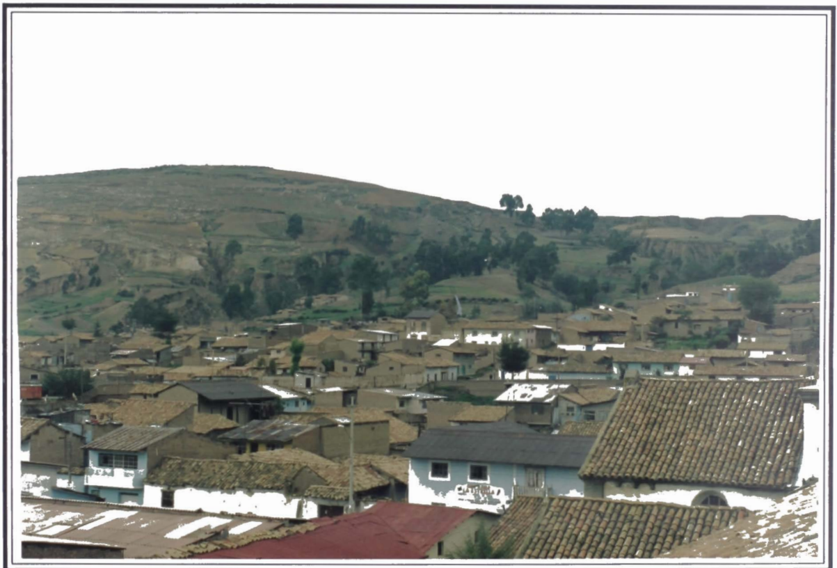
Foto 8: En la vista panoramica se aprecia el predominio de los techos de dos aguas con tejas. Es una cobertura muy pesada que lo convierte en un factor de vulnerabilidad si se encuentra sin mantenimiento actualmente.
