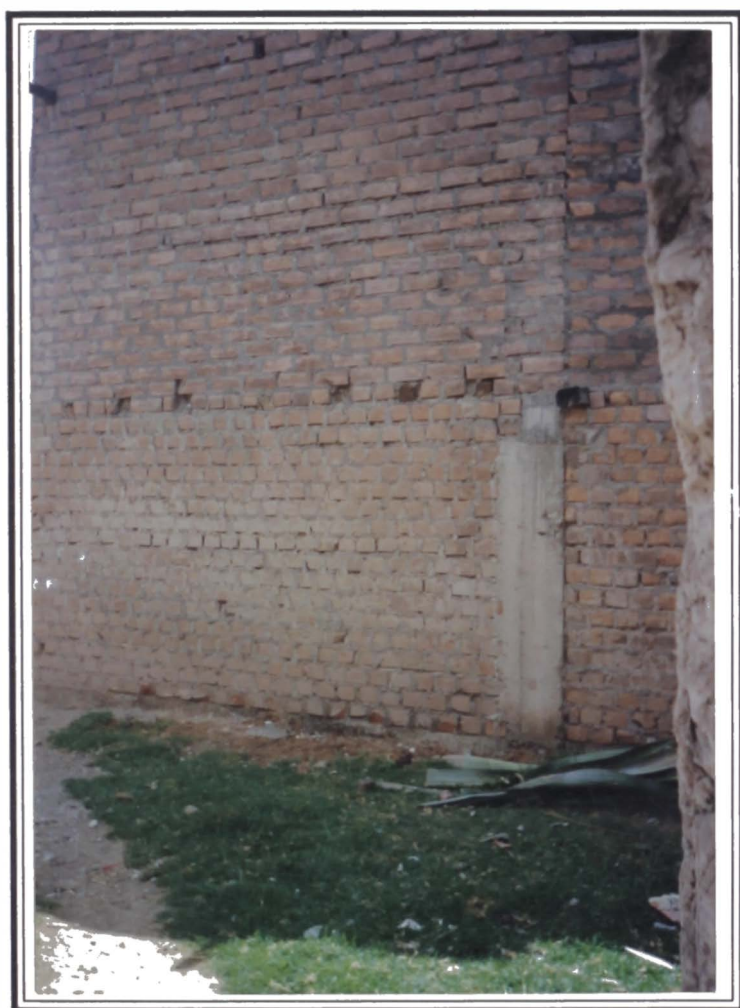
Foto 5: En la vista se observa la deficiencia en las conexiones entre techos, muros y cimentación, pues el confinamiento de muros está muy espaciado, las columnas no llegan a todos los pisos superiores, y la viga solera y/o de amarre del piso superior no existe.
