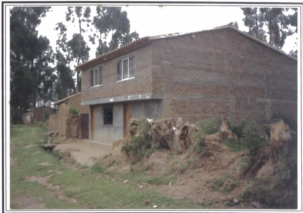
Foto 5: En la vista se observa la deficiencia en las conexiones entre techos, muros y cimentación, pues el confinamiento de muros está muy espaciado, las columnas no llegan a todos los pisos superiores, y la viga solera y/o de amarre del piso superior no existe.
