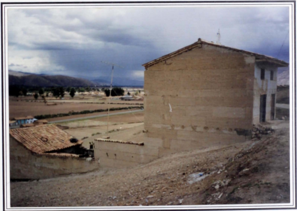
Foto 2: En la vista se observa la misma edificación anterior mostrándose la pendiente pronunciada del terreno en esta parte de la ciudad (NO). Este tipo de construcciones se han ubicado mayormente en las partes limítrofes entre los distritos de Jauja y Yauyos, razón por la cual deberían tener un mejor tratamiento para evitar posibles deslizamientos o asentamientos que podrían afectar las viviendas de adobe.
