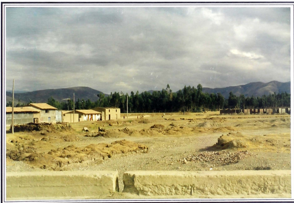
Foto 5: Las viviendas vecinas al Grupo Habitacional 'RIO VERDE', con la futura construcción en latente peligro de inundación.
