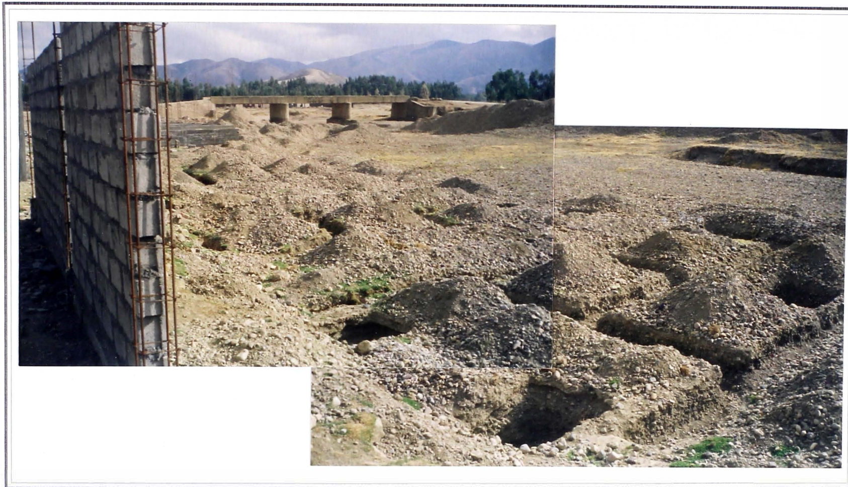
FOTO 12: En la vista se observa la granulometría del material del lecho, y la deficiencia en el diseño de la cimentación así como la falta de nivelación del terreno proyectado para el Conjunto Habitacional "RIO VERDE"
