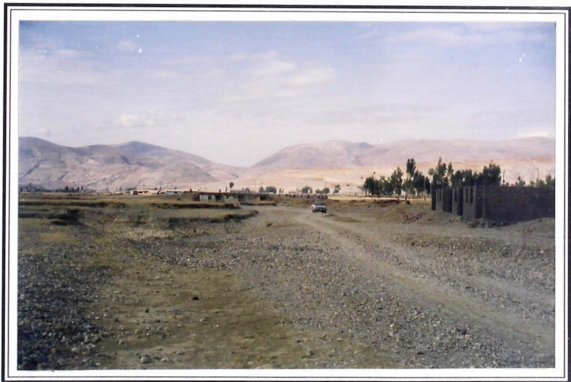
Foto 7: Observando hacia aguas abajo, la construcción se ubica en el lecho del río. En esta última avenida el cauce de estiaje estuvo apegado a la margen derecha y por este transita un automovil. Como se ve, no existe mayor diferencia de nivel entre el lecho y la ribera.
