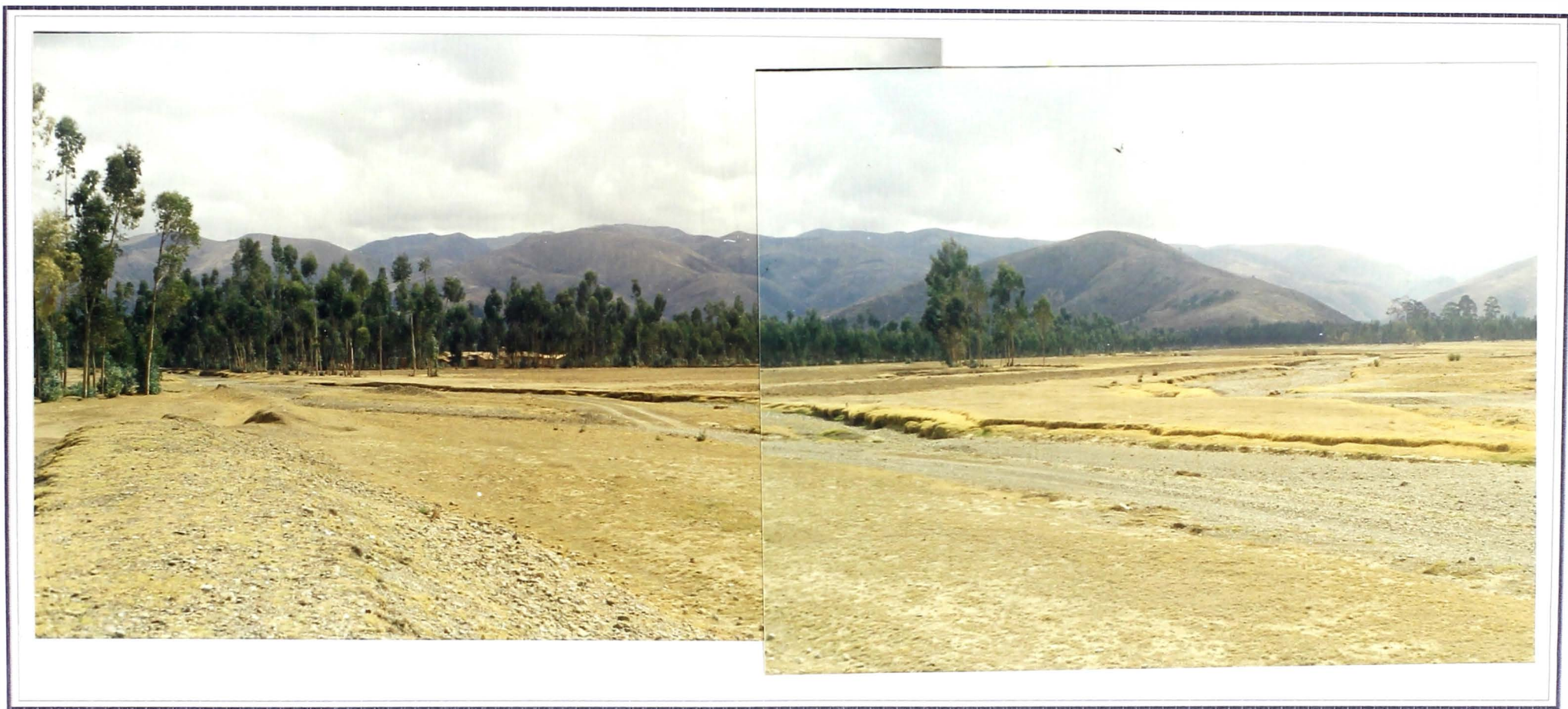
FOTO 1: Vista de agua arriba del Puente, en la intercepción de dos ríos para formar el río Yacus. El lecho es amplio el cauce de estiaje es superficial y la ribera no definida. Se muestra una capa de limo-arenoso color beige. Es importante el sembrado de árboles que protege contra el ensanchamiento. Al fondo se ve la quebrada.
