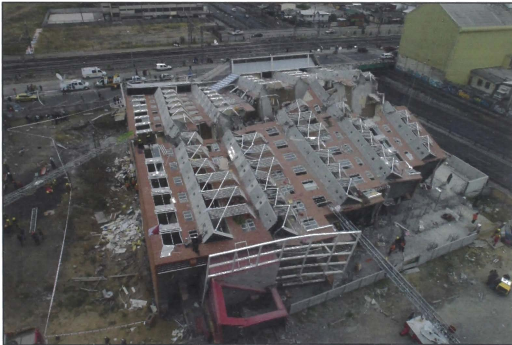
Figura N°1.13: Falla por volteo de edificio Alto Río en Concepción, Chile. Año 2010
