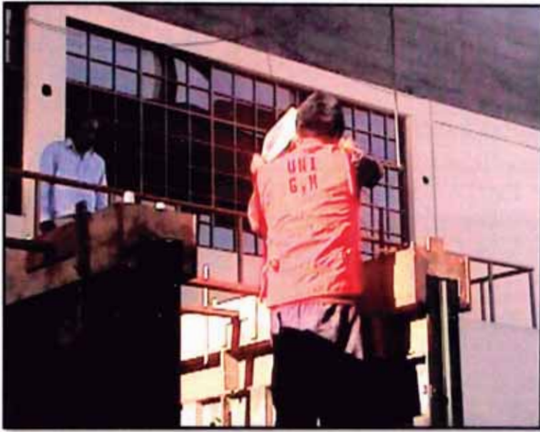
Fig. 3.17 Vaciado de placas de concreto
