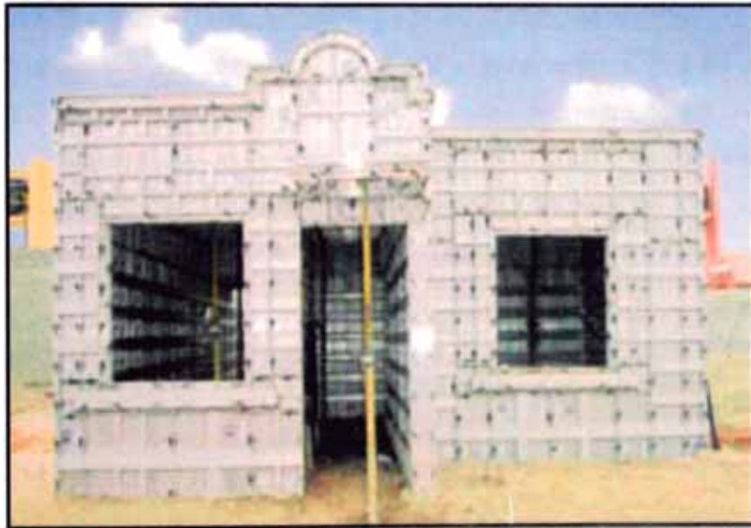
Fig. 2.25 Comparación entre el encofrado y el desencofrado de una vivienda, fuente catálogo Forsa.
