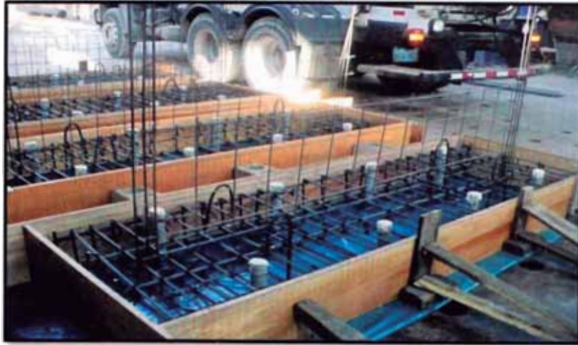
Fig. 3.8 Vaciado de cimentación de muro.
