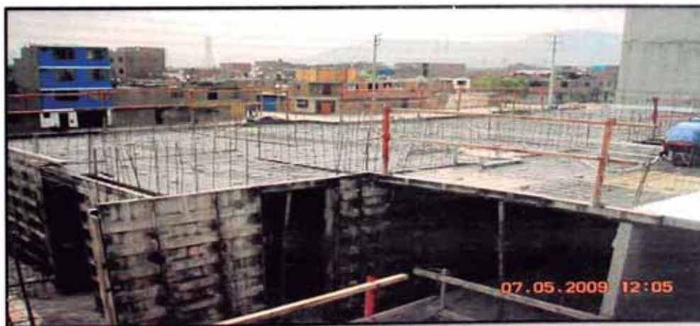
Fig. 2.17 Encofrado monolítico de muros y losa
