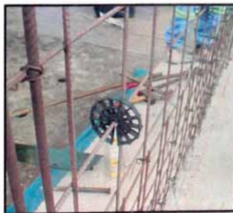
Fig. 3.12 Vista de los separadores de mallas para muros de 8cm de espesor
