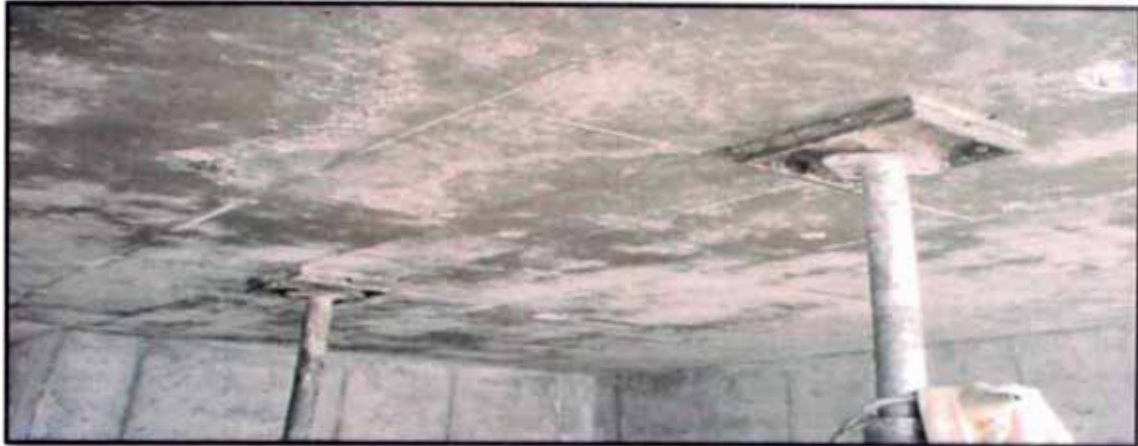
Fig. 2.18 Vista de los puntales dejados luego de desencofrar muros y losas
