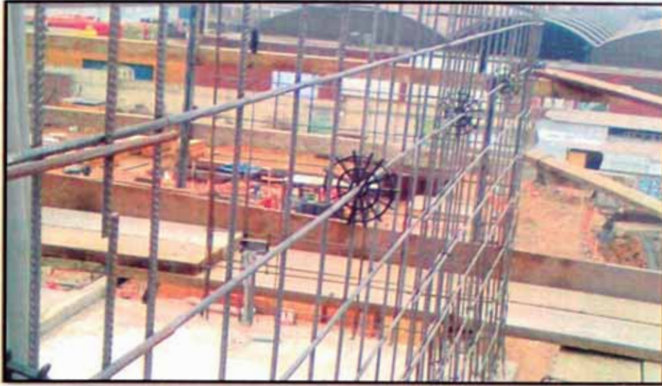
Fig. 2.14 Vista panorámica de Mallas Electrosoldadas en la construcción de Edificios de Muros de Ductilidad Limitada, construcción del Proyecto Parques del Garezon, Lima – Perú 2010
