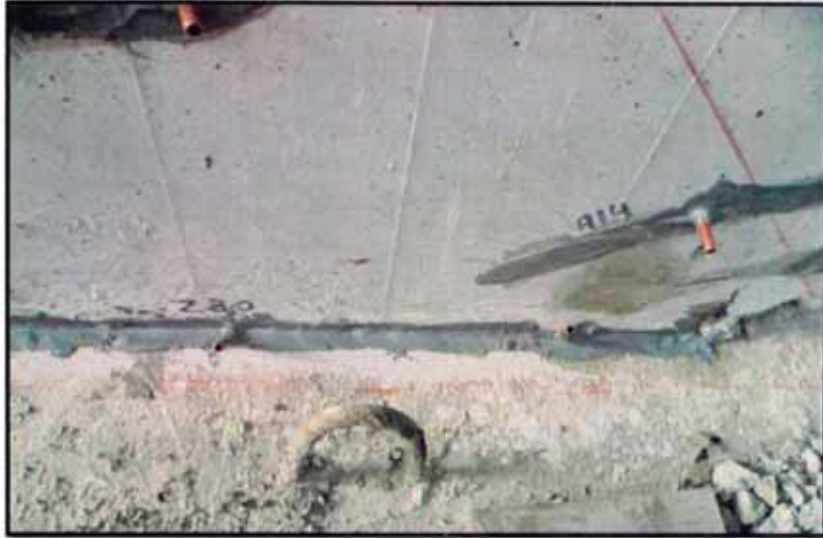
Fig. 3.30 Sellado de fisura producto de la falla por cortante
