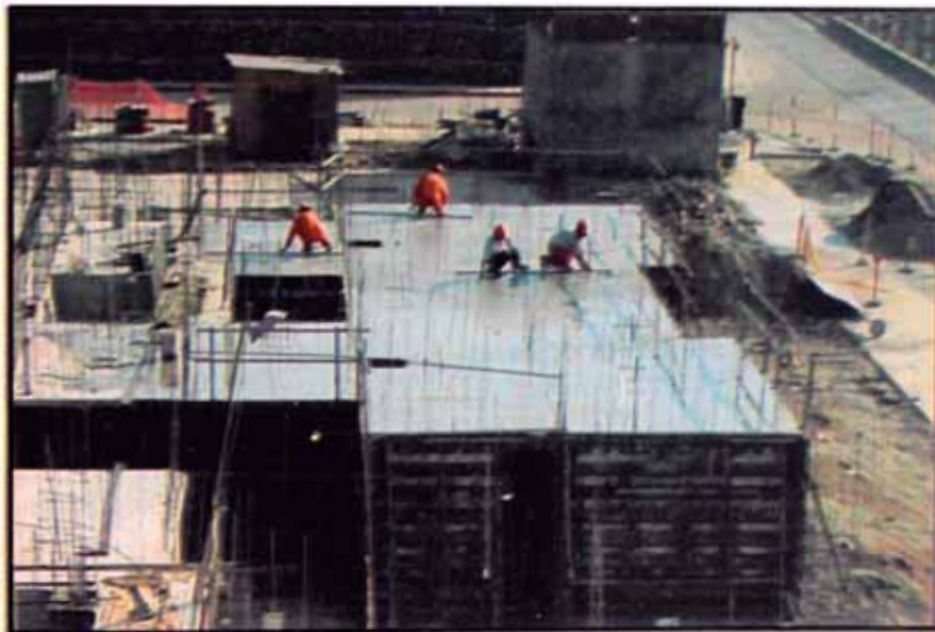
Fig. 2.11 Vista panorámica del acabado de losa de techo. Proyecto Los Parques del Agustino, Lima – Perú 2010
