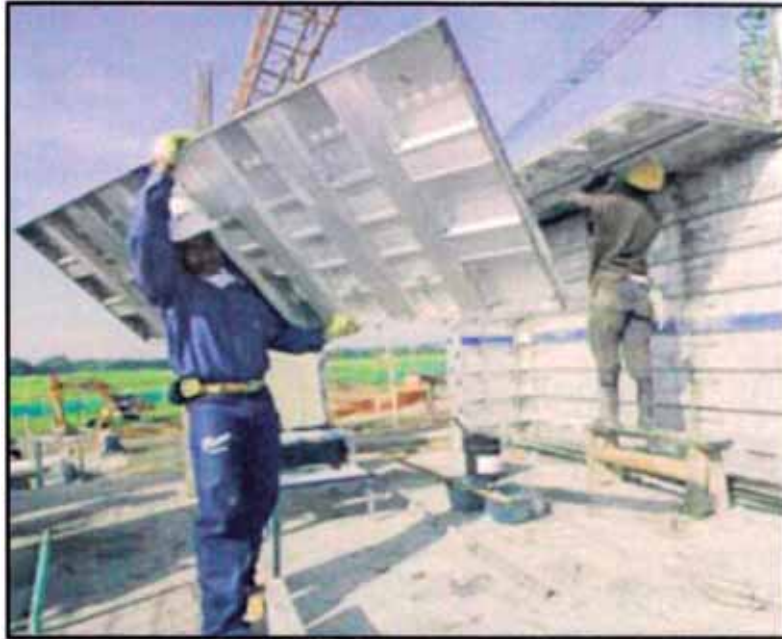
Fig. 2.16 Vista del encofrado metálico y su trabajabilidad para con el operario
