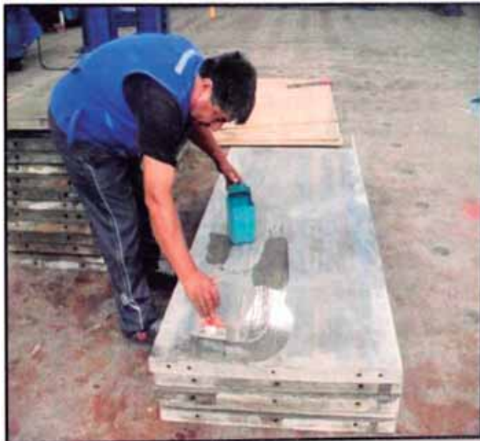
Fig. 3.14 Aplicación del aditivo desmoldante Z-Cron
