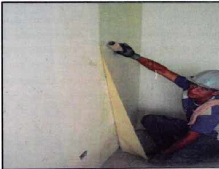
Fig. 2.31 Proceso de instalación de papel colomural
