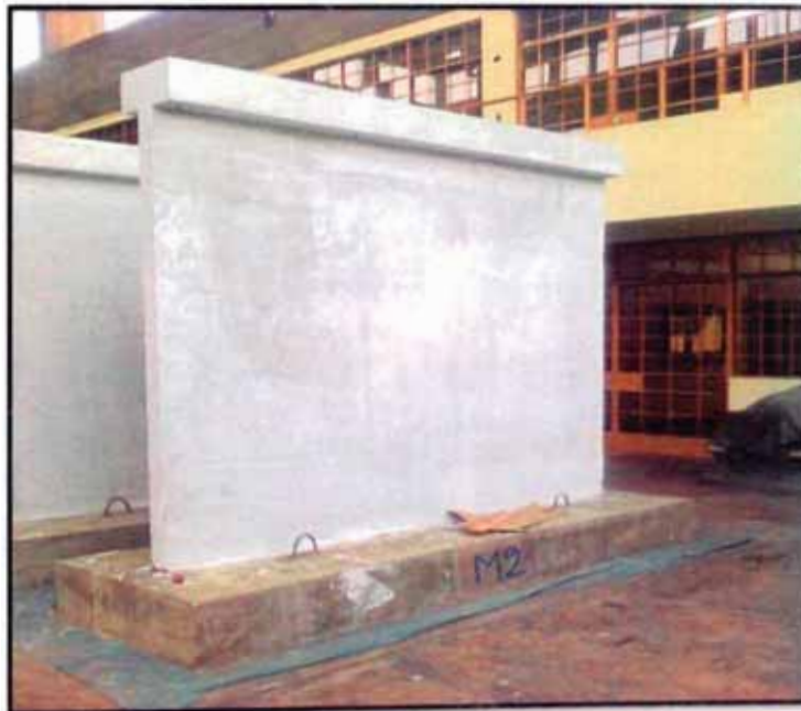
Fig. 3.24 Vista del acabado de los muros
