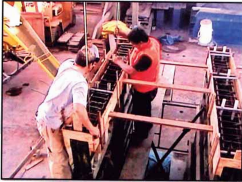
Fig. 3.19 Vista del encofrado de madera acoplado al encofrado metálico
