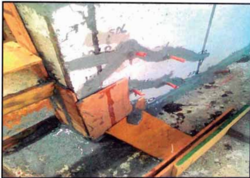
Fig. 3.33 Vista del Encofrado y vaciado de los talones de muro
