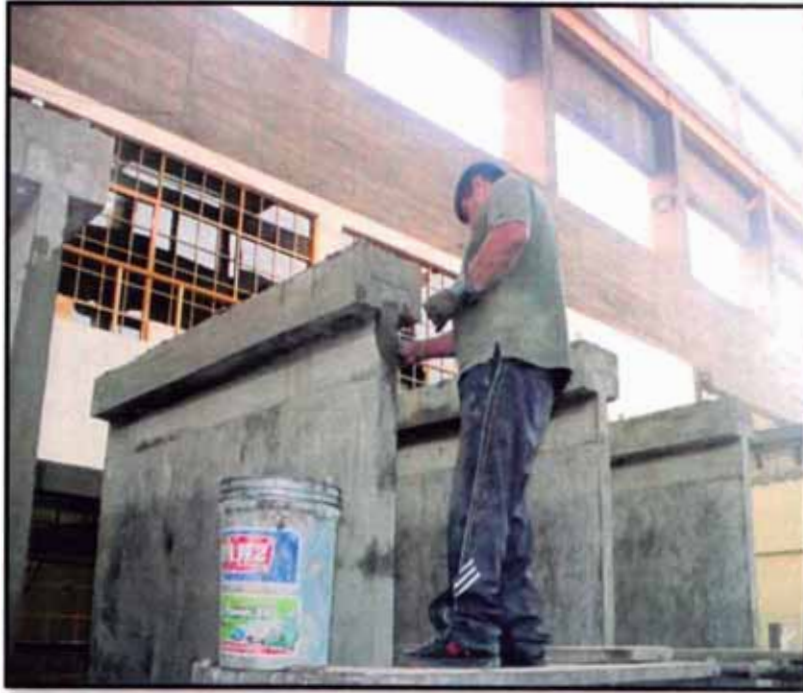
Fig. 3.23 Resane de Superficie de muros
