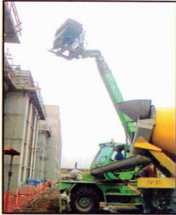
Fig. 2.10 Vista panorámica del vaciado de concreto premezclado utilizando telehandler para el vaciado de concreto. Proyecto Los Parques Garezon, Lima – Perú 2010
