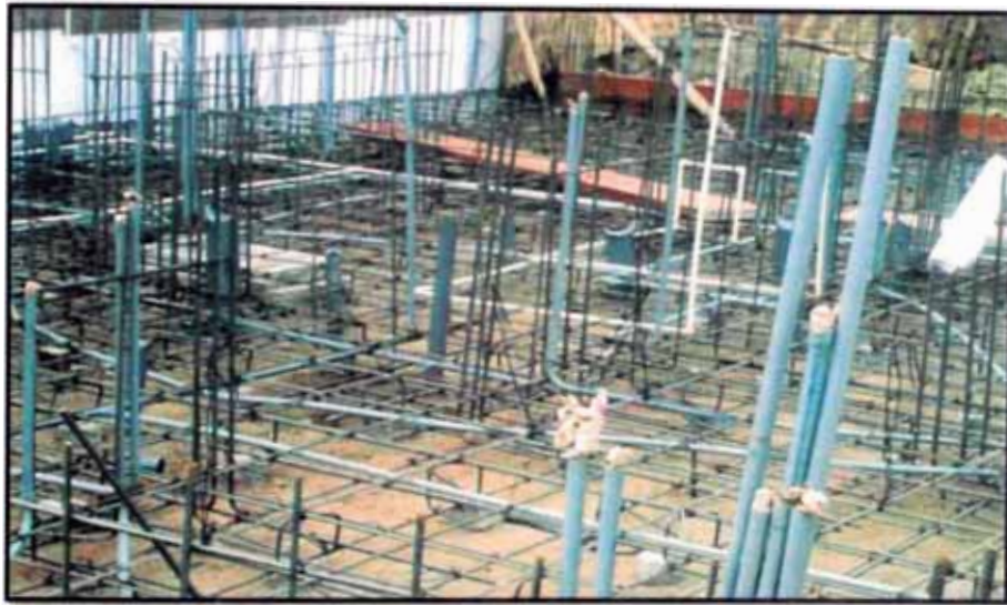
Fig. 2.21 Vista del acero de refuerzo y tuberías de los servicios en las plateas de cimentación
