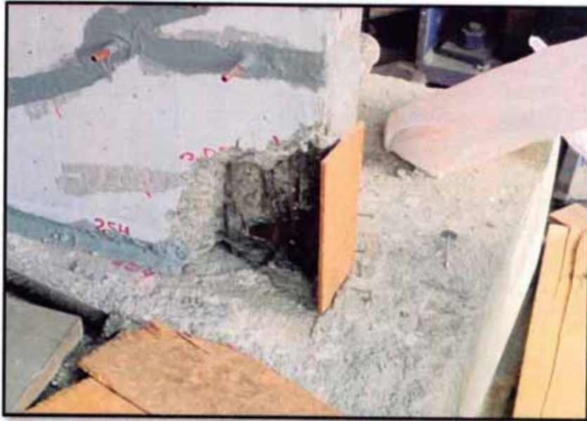
Fig. 3.32 Encofrado de los talones de muro
