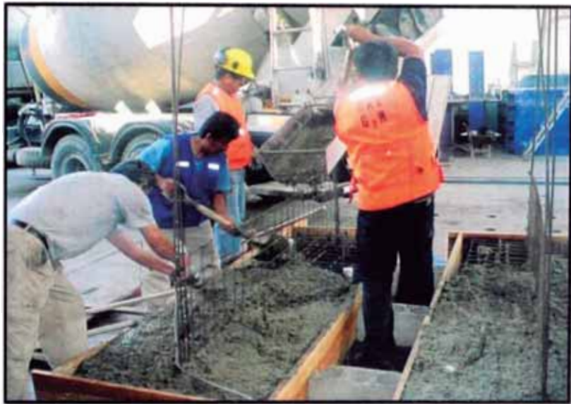
Fig. 3.9 Encofrado y acero de refuerzo de cimentación de muro.
