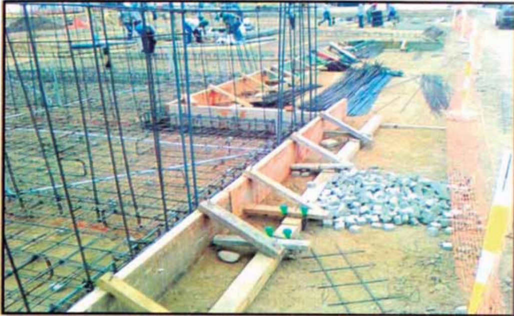
Fig. 2.13 Vista panorámica del uso del acero de refuerzo dúctil, en la construcción de edificios de ductilidad limitada. Proyecto Parques Garezon, Lima – Perú 2010
