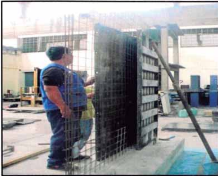
Fig. 3.15 Colocación de la fomaletas metálicas como encofrado de los muros
