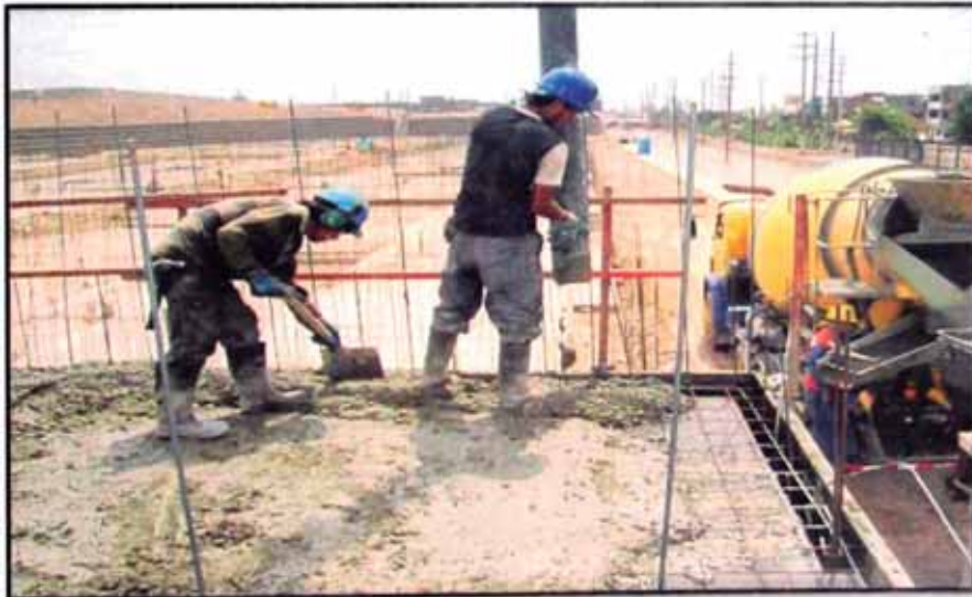
Fig. 2.28 Proceso de vaciado de conjunto monolítico losa - muro
