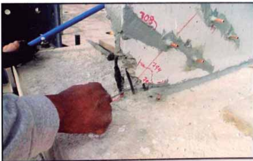
Fig. 3.31 Limpieza de talones del muro
