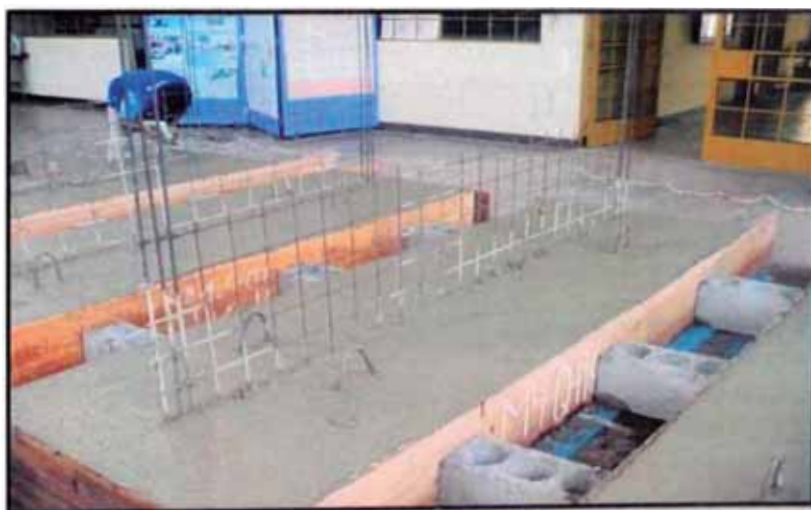
Fig. 3.10 Acabado de superficie de cimentación.
