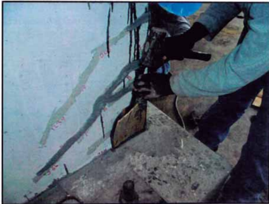
Fig. 3.35 Desencofrado de talones de muro
