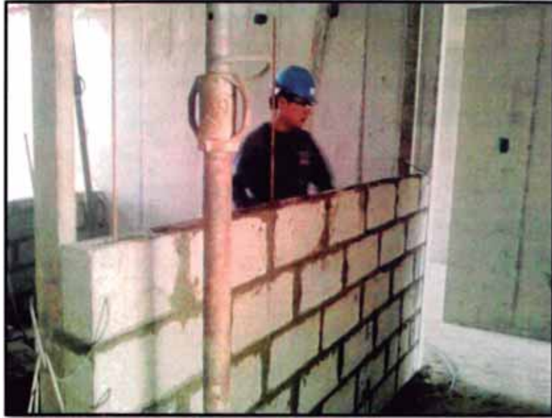
Fig. 2.30 Proceso de asentado de bloques P-9 como tabiquería
