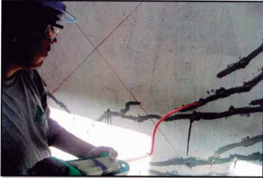
Fig. 3.34 Inyectado a presión de fisuras a través de aditivo EUCOPOXI INJECTION RESIN .
