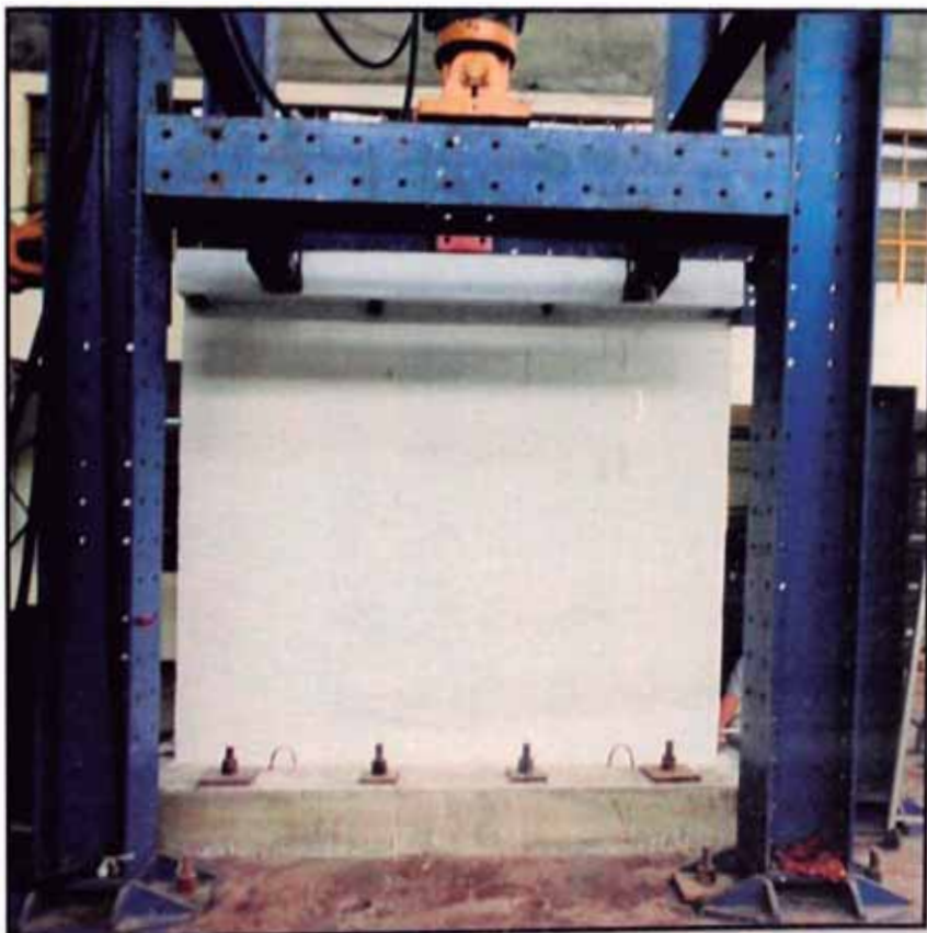
Fig. 3.37 Vista de muro reparado, listo para ser sometido al ensayo de carga lateral cíclica
