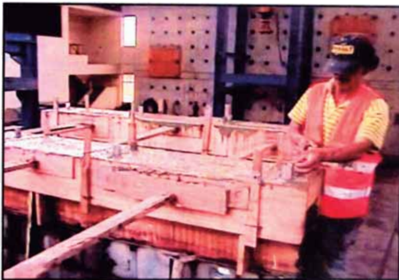
Fig. 3.20 Ajuste de pase de PVC en viga de transferencia
