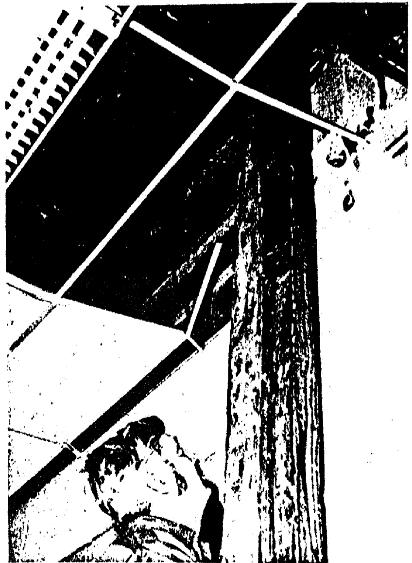
FOTO N° 16 - Servicio de Ofi- cinas de San Fernando . Apuntala- miento de techo reticulado .
