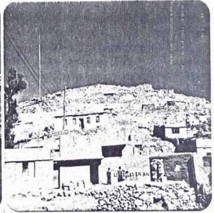
ACERCAMIENTO DE LAS VIVIENDAS CIMENTADAS EN ESTA ZONA . ( 18 )
