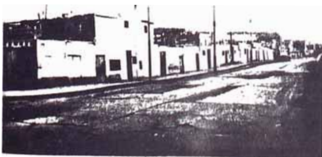
Foto N° 12. Nuevamente viviendas en la zona 6, pero aquí se aprecia el suelo muy agrietado y deformado.
