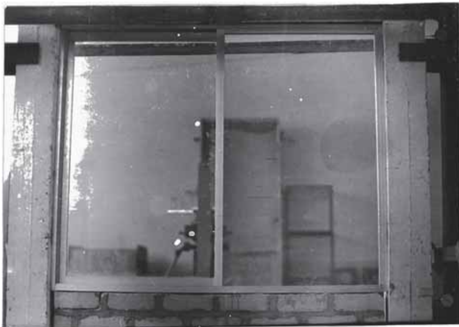
FOTO N° 11 Ventanas de aluminio de un paño fijo y el otro corredizo
