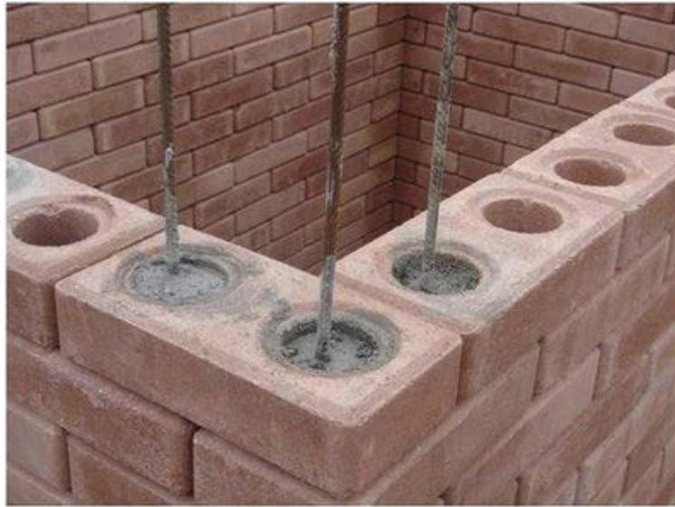
**Figura 2.3 Sistema de albañilería armada utilizado**
