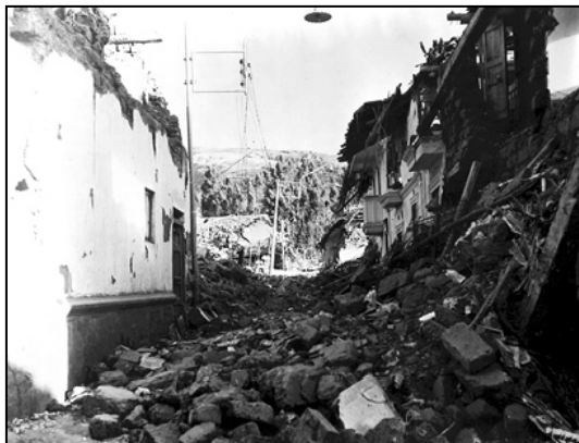
Figura III-4: Imagen de viviendas afectadas en Ancash en el sismo de 1970
