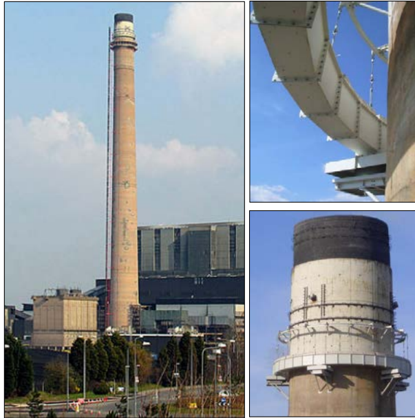
Figura I-5: Chimenea de la Central Térmica Rugeley (Inglaterra)
