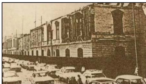
Figura III-2: La Casa de San Marcos afectada por el sismo de 1966
