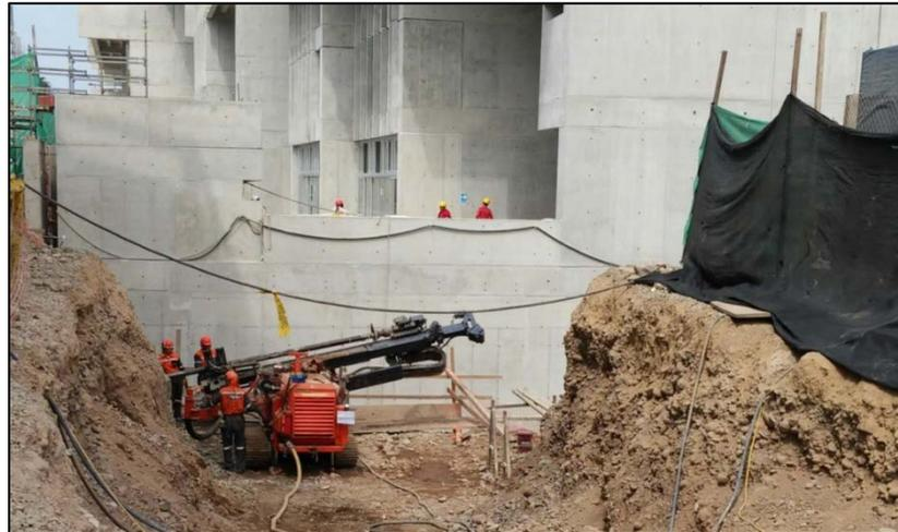
**Figura 3.4 Vista proceso de perforación de anclajes activos permanentes. Proyecto: UTEC – Lima Febrero 2014. Cortesía Pilotes Terratest Perú S.A.C**
