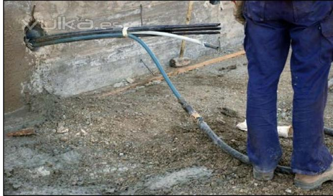
**Figura 3.5 Vista proceso de inyección interior y exterior anclajes activos permanentes**
