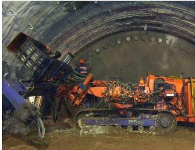
**Figura 2.11 Perforadora Hidráulica sobre Orugas con Martillo rotopercutor**
