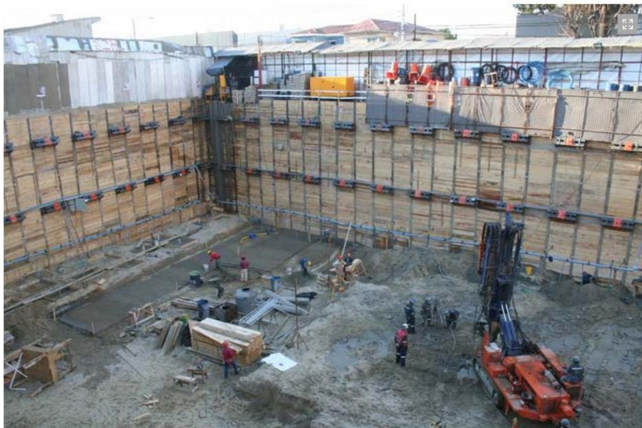
**Figura 1.10 Vista de una estabilización con Muro Berlínés**
