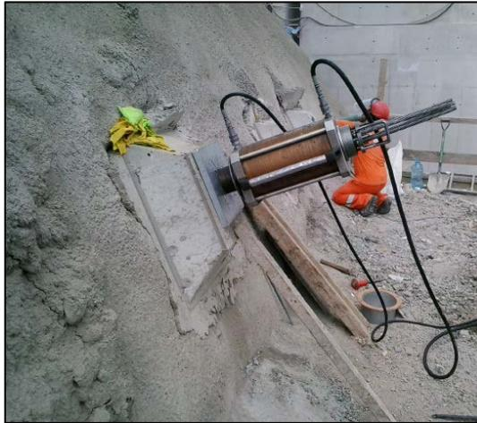
**Figura 3.6 Vista proceso de tensados anclajes activos permanentes.
