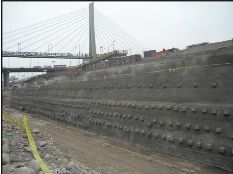
**Figura 2.9 Vista de una estabilización con Soil Nailing. Proyecto: Vía Parque Rímac – Lima Diciembre 2012. Cortesía Pilotes Terratest Peru S.A.C**
