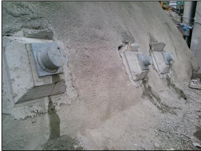
**Figura 3.7 Vista de la terminación de cabezas de anclajes activos permanentes. Proyecto: Nuevo Campus UTEC – Lima Febrero 2014. Cortesía Pilotes Terratest Peru S.A.C**
