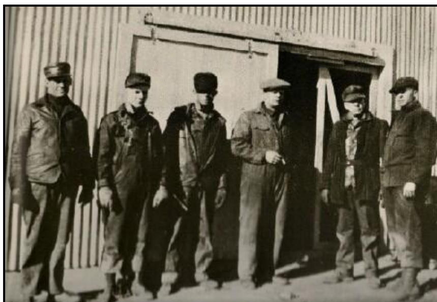
Instalación ESP # 1. Arriendo de Phillips Petroleum, cerca de Burns, Kansas, 1928. Arutonoff es el tercero desde la derecha, se muestra con los empleados originales de Reda.
