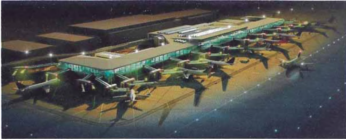
Figura N° 4.20.- Proyecto Aeropuerto de Dubai Concourse 4, construido por ALEC.
