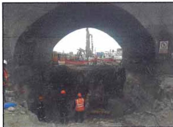
Figura N° 58. Trabajos de sondeo horizontal en pilares del Puente Trujillo
