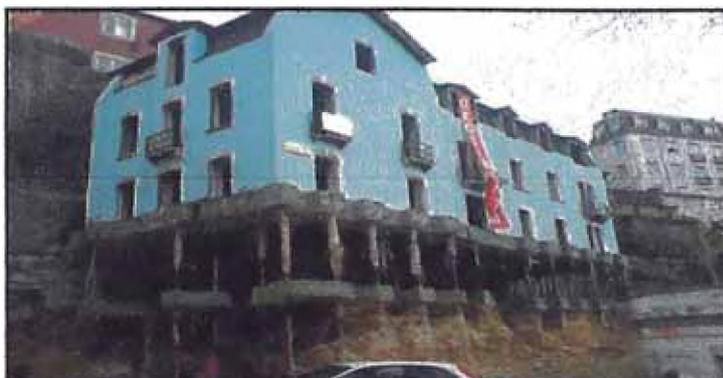
Figura Nº 3. Recalce de estructura existente para excavación de sótanos en Alcántara, Lisboa
