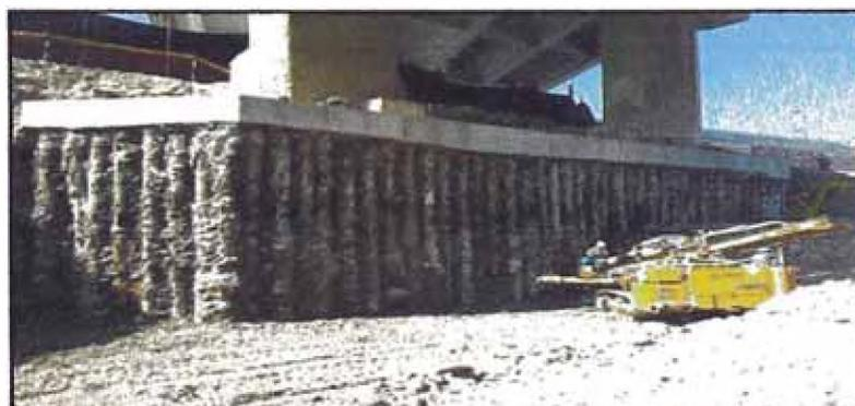
Figura Nº 5. Contención con pantalla de micropilotes en excavación bajo el puente Ricardo Palma – Lima
