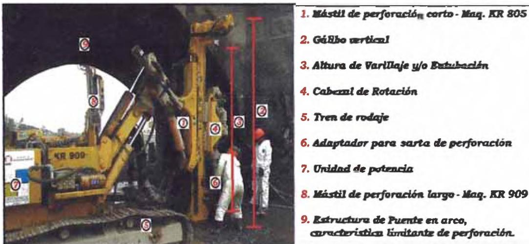
Figura N° 19. Equipo de perforación de micropilotes – Puente Trujillo
