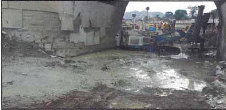
**Figura N° 93. Falta de drenaje adecuado que impide continuar la perforación de micropilotes de manera segura**
