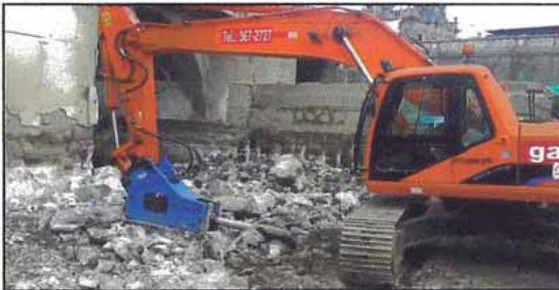
**Figura N° 94. Destrucción de material rocoso para evitar problemas en la ejecución de micropilotes como desviaciones y rotura de materiales**
