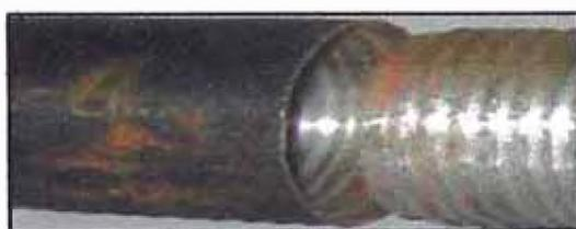
Figura N° 28. Unión simple macho - hembra
