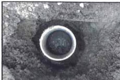
Figura N° 33. Vista en planta de micropilote inyectado – Puente Trujillo
