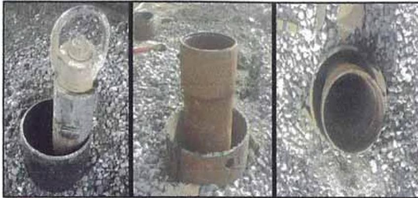
Figura N° 32. Armadura colocada en micropilote perforado
