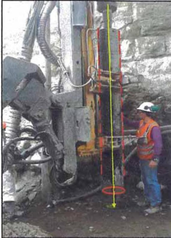
Figura N° 26. Posicionamiento del equipo
