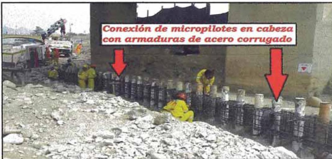
Figura N° 34. Ejecución de viga de coronación de pantalla de micropilotes en el puente Ricardo Palma - Lima
