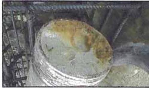
Figura N° 62. Mezcla pobre de cemento en cabeza de micropilote
