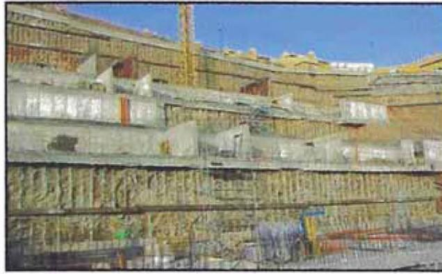
Figura Nº 6. Contención con pantallas de micropilotes en Málaga – España
