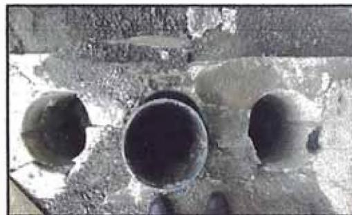
**Figura N° 25. Muro guía de micropilotes Ricardo Palma**
