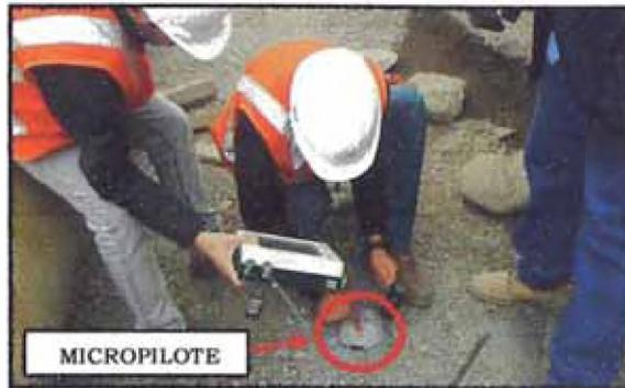
Figura N° 92. Ejecución de ensayos PIT en micropilotes de frente Vía Evitamiento
