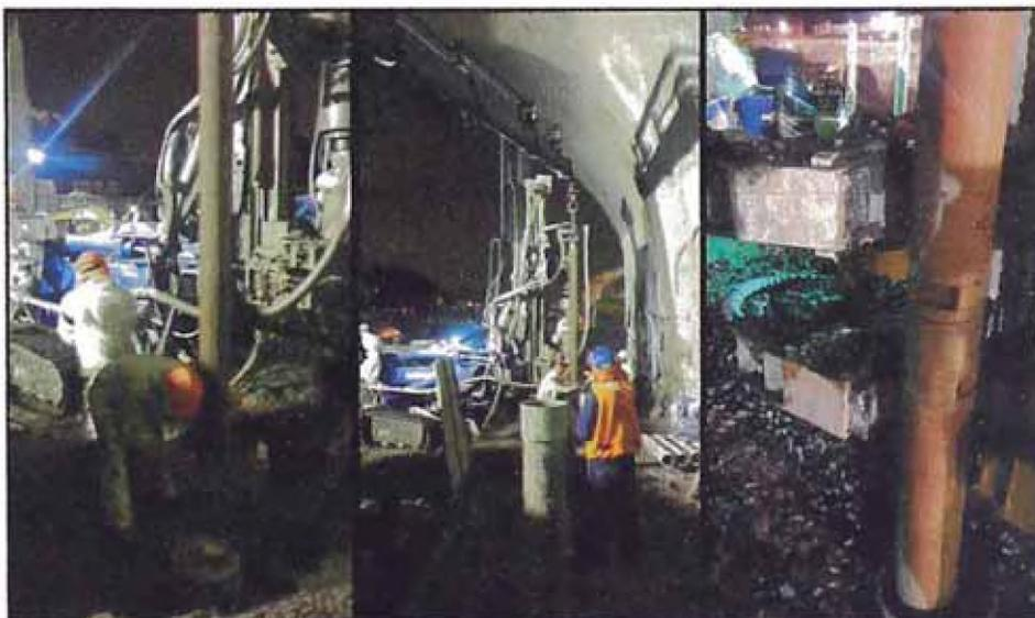
Figura N° 31. Colocación de armadura de micropilote
