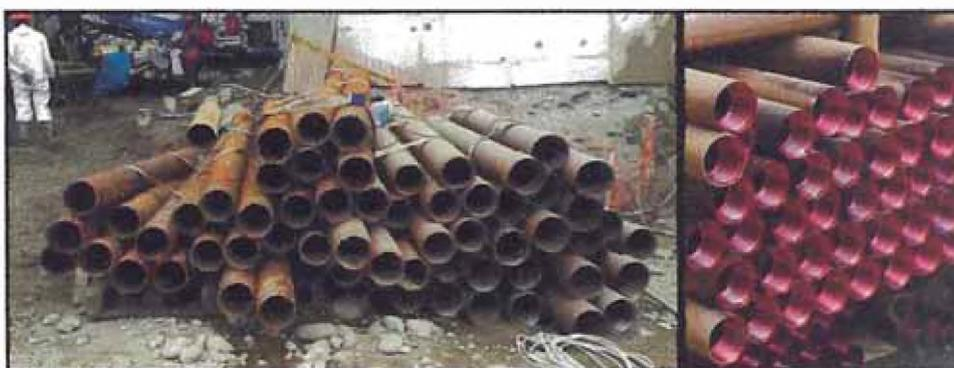
Figura N° 10. Armaduras tubulares de acero para micropilotes
