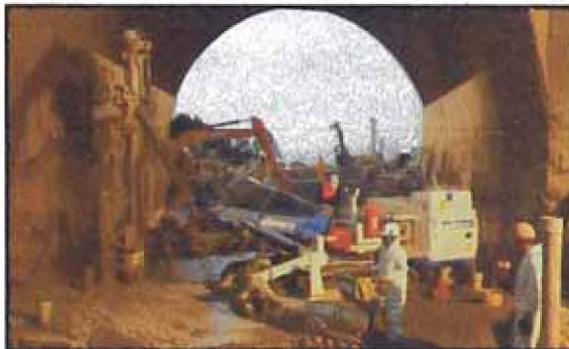
Figura N° 27. Perforación de micropilotes a bajo gálibo – Puente Trujillo
