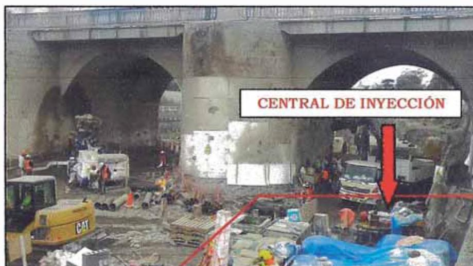
Figura Nº 18. Central de inyección de micropilotes – Puente Trujillo
