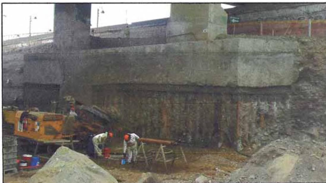
**Figura N° 55. Ejecución de anclajes en pantalla de micropilotes puente Ricardo Palma**
