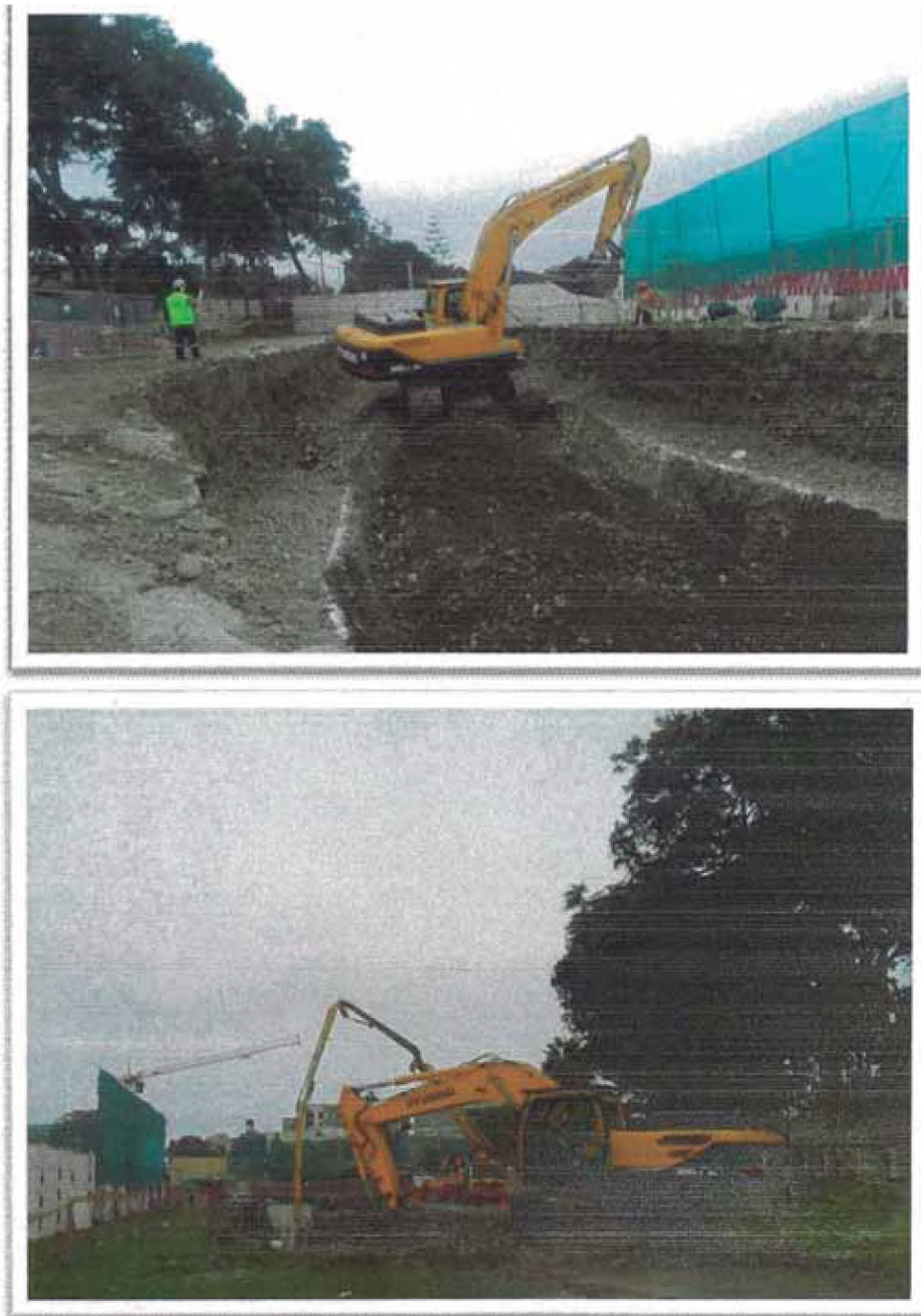
Figura N° 05: Excavaciones para el Túnel Colegio Markham.
