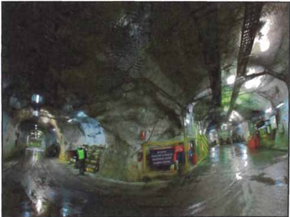
Fig. 3: Fotografía Rampa Principal – Ejemplo de Mina Subterránea
