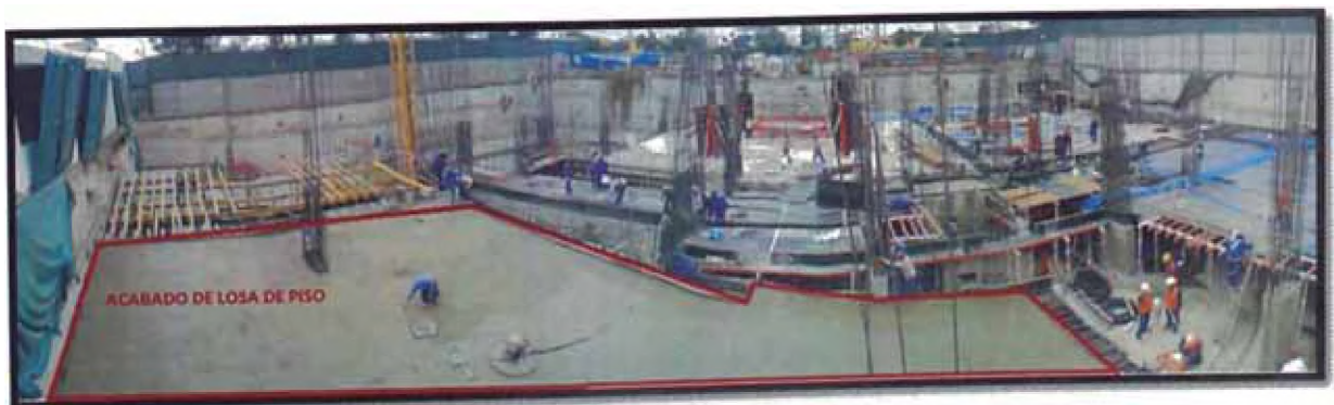
Figura N°39.- Vista de losa con acabado barrido.
