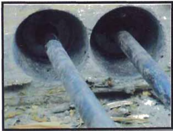
Figura N°40.- Vista de cable postensado desencofrado.
