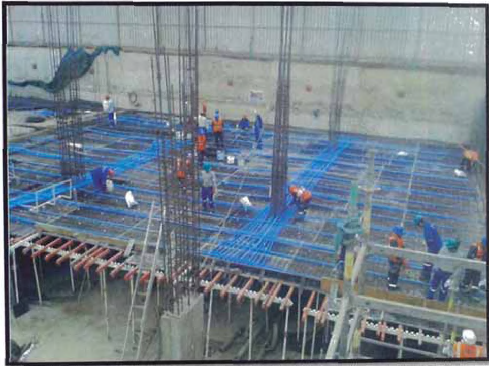
Figura N°36.- Colocación de cable postensado terminado.
