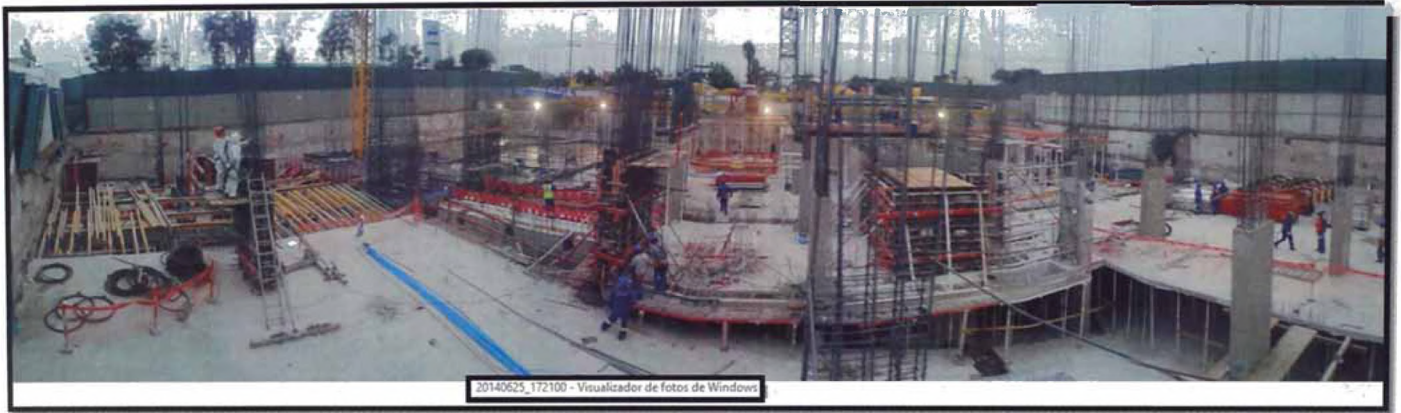
Figura N°43.-Vista último vaciado de losa.
