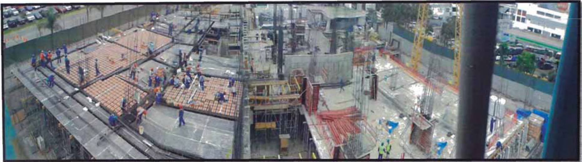
Figura N°44. -Vista de torre aplicando sistema de losa tradicional. (PROYECTO PARK OFFICE – LA MOLINA)
