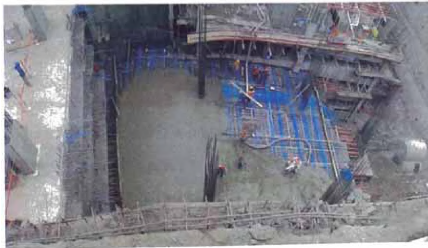
Figura N°6: Colocación de concreto en losa postensada.
