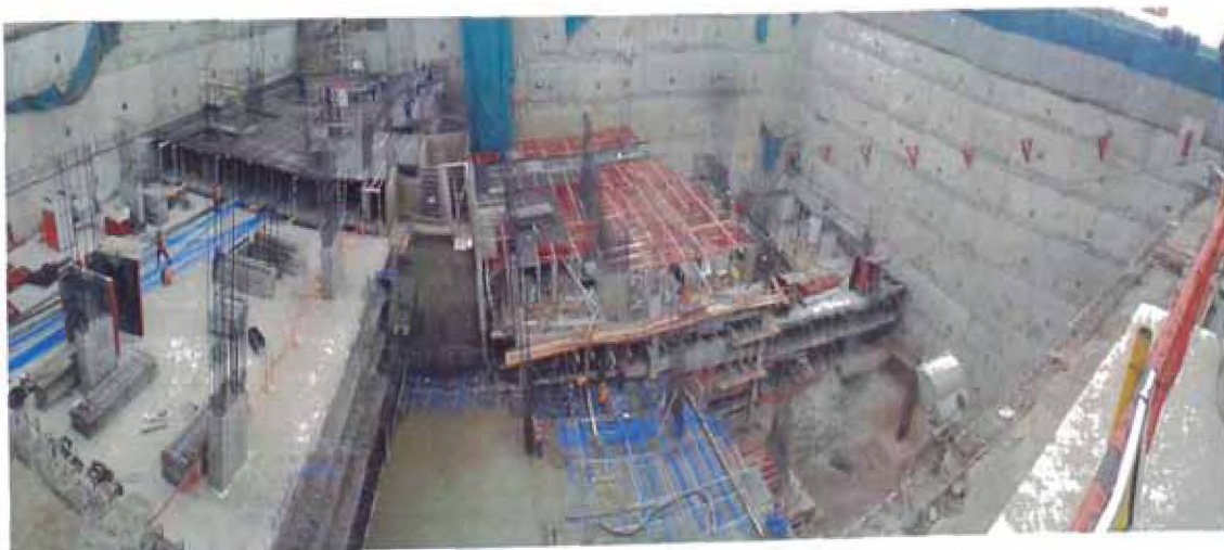
Figura N°13: Losa postensada Proyecto Park Office- La Molina
