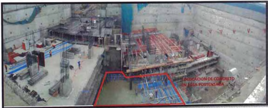
Figura N°38.- Colocación de concreto en losa postensada.
