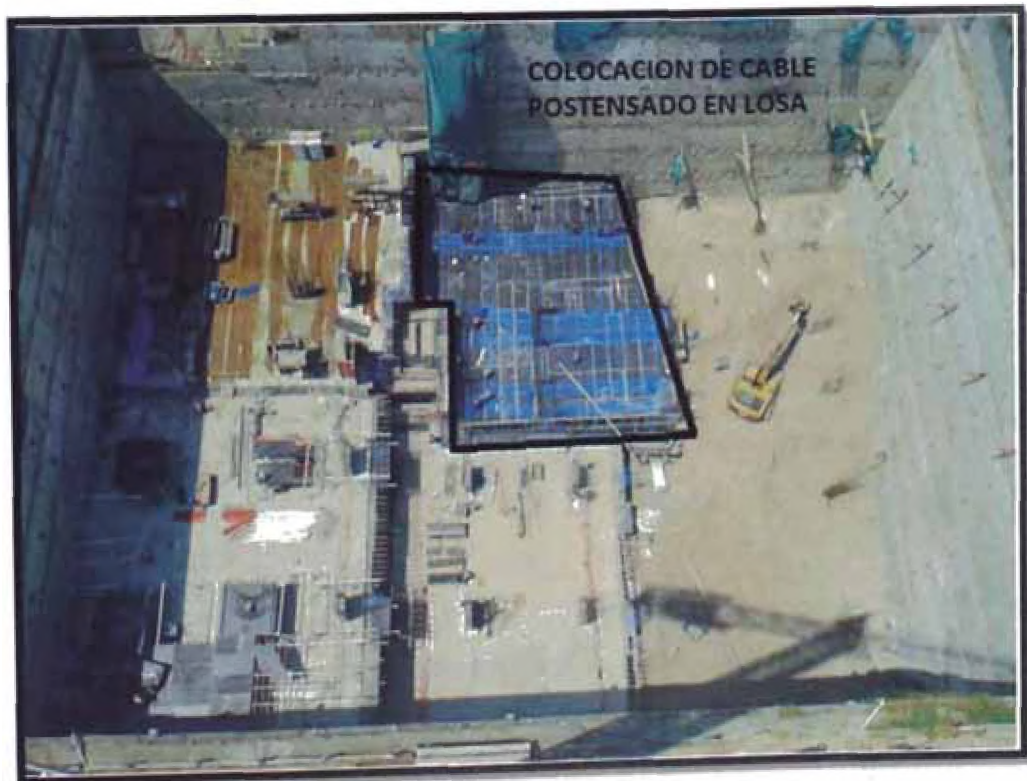
Figura N°37.- Vista de losa con cable postensado.
