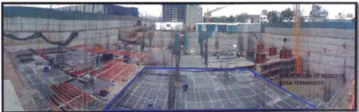
Figura N°26: Colocación de acero de losa termina.
