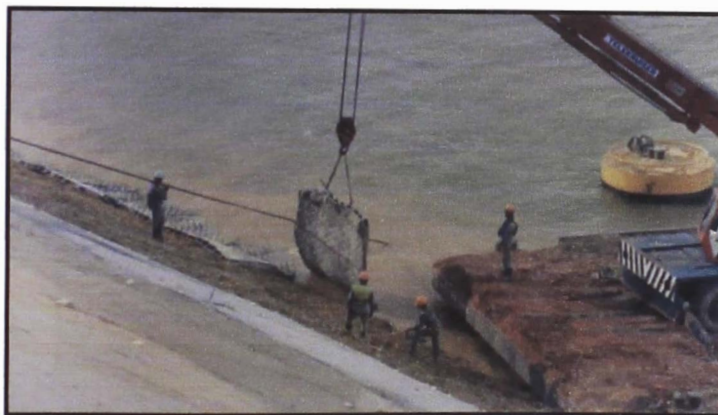
Foto N° G.13. Instalación de geoceldas prefabricadas.
