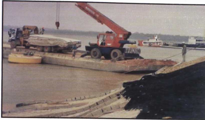
Foto N° G.12. Barcaza con geoceldas prefabricadas.
