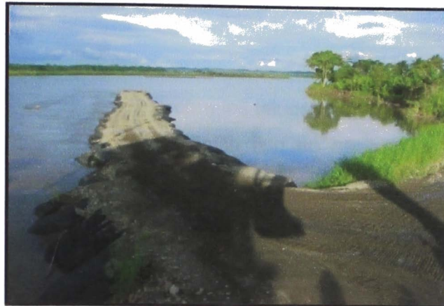
Foto N° G.9. Sistema de protección culminado.
