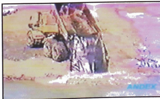
Foto N° G.5. Deslizamiento de la geobolsa. Fuente Andex.
