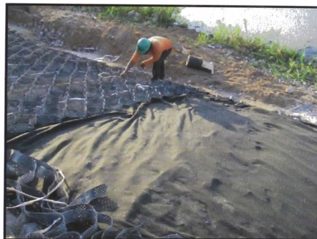
Foto N° G.14. Proceso constructivo en talud. Fuente Andex.
